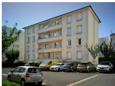
Un des quatre immeubles collectifs de la rue de Blanzat, depuis l'est (années 1950). Phot. Christian Parisey IVR84_20196300252NUC4A
