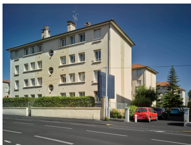
Ensemble des quatre immeubles collectifs de la rue de Blanzat, depuis le sud-ouest (années 1950). Phot. Christian Parisey IVR84_20196300253NUC4A
