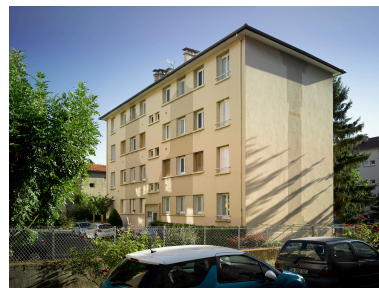
Un des quatre immeubles collectifs de la rue de Blanzat, depuis l'ouest (années 1950). Phot. Christian Parisey IVR84_20196300251NUC4A
