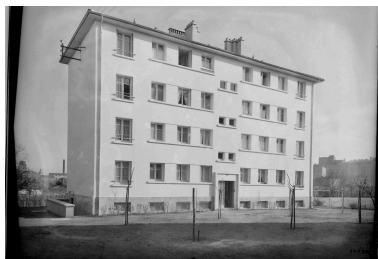
Élévation ouest de l'un des immeubles collectifs Michelin, rue de Blanzat. Vue prise vraisemblablement au début des années 1960. Repro. Service de collecte et de valorisation des collections historiques de la Manufacture française des pneumatiques Michelin., Autr. auteur inconnu IVR84_20236300192NUC
