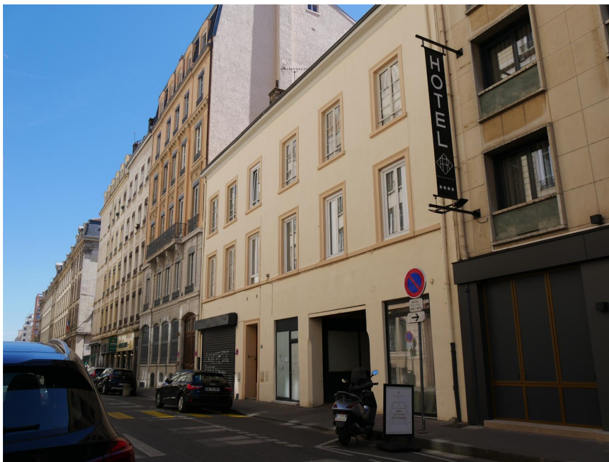
Vue d'ensemble du site
