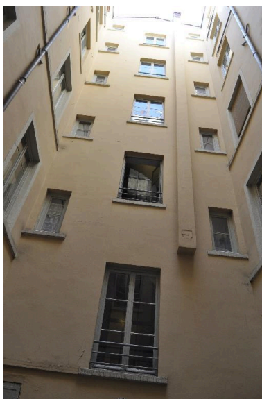
Elévations sur cour, vue de la cage d'escalier Phot. Catherine Guégan IVR84_20166900693NUCA
