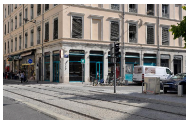
Elévation latérale, vue rapprochée du rez-de-chaussée Phot. Catherine Guégan IVR84_20166900692NUCA
