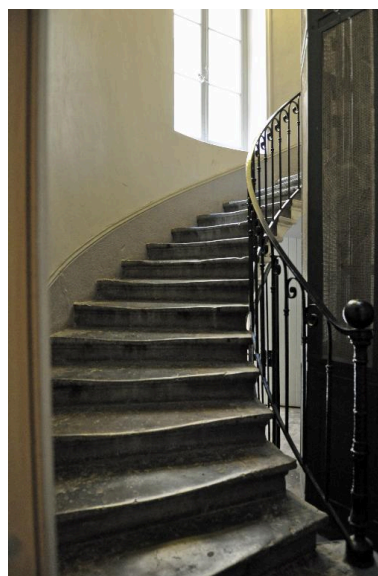
Vue intérieure : le départ de l'escalier du 29 rue de Marseille Phot. Catherine Guégan IVR84_20166900697NUCA
