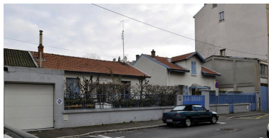
Vue en situation Phot. Julien Defillon IVR82_20106900829NUCA
