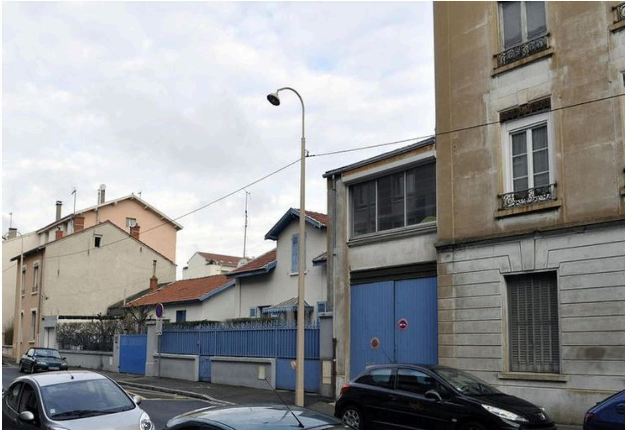
Façades antérieures de la maison et du garage
