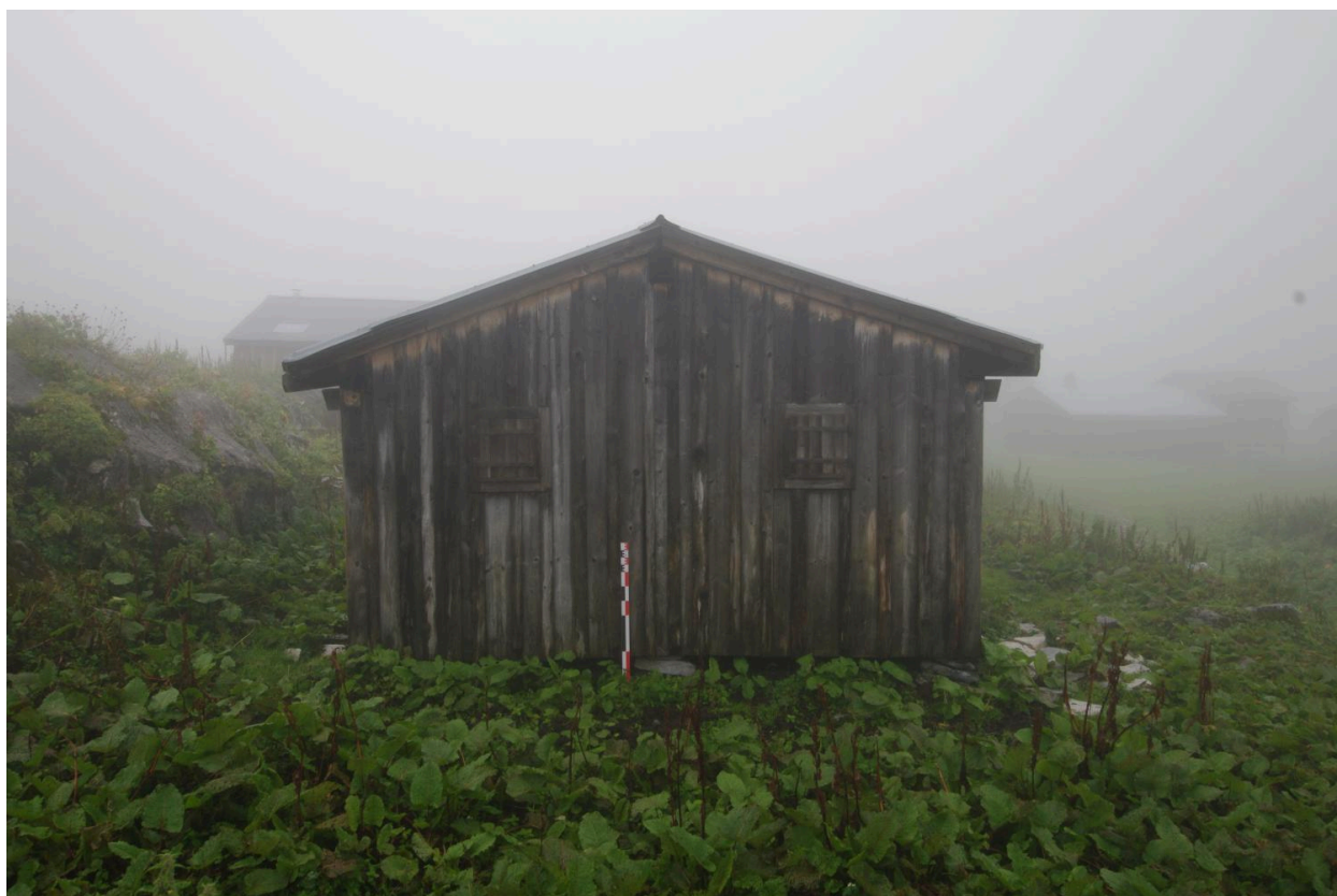
Mur pignon orienté au nord
