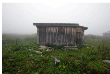
Façade antérieure du chalet orientée à l'ouest Phot. Jocelyn Laidebeur
