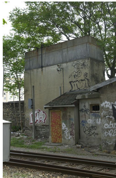
Réservoir ? Phot. Bernard Ducouret IVR82_20036903213NUCA
