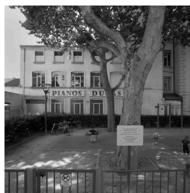
Vue générale ouest Phot. Eric Dessert IVR82_20056900129NUCA
