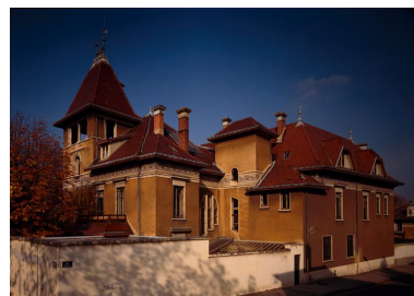
Villa Berliet, vue sud Phot. Alain Franchella IVR82_19966900295PA
