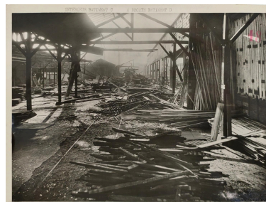
Intérieur bâtiment B et à droite bâtiment D - Photo extraite des dossiers de dommages de guerre - 1948 (AD Rhône) Phot. Alice Giacovelli IVR84_20226900444NUC
