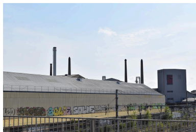
Aciéries de Longwy en 2022 vues depuis l'autopont Phot. Nadine Halitim-Dubois IVR84_20226900586NUCA
