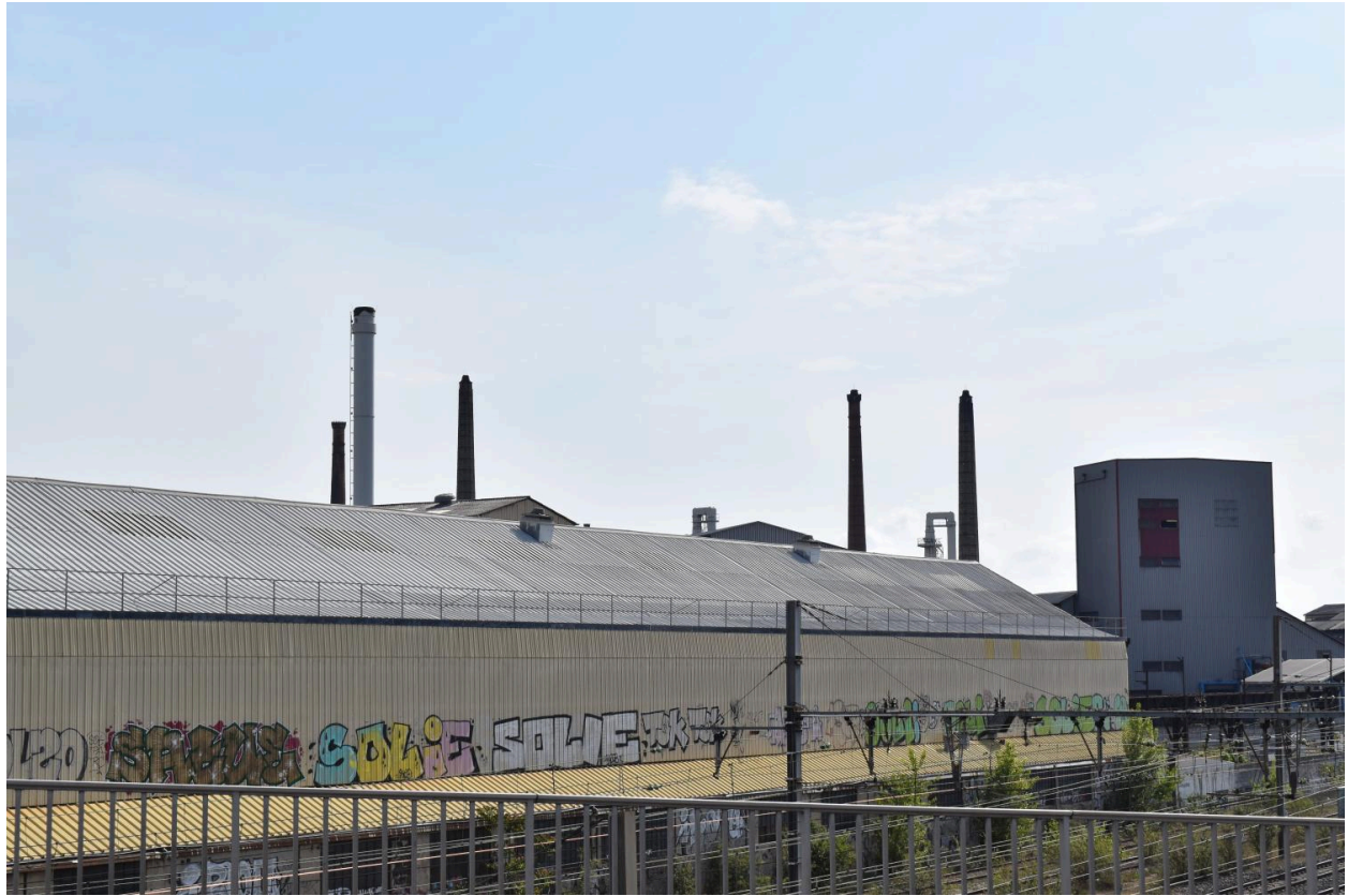
Aciéries de Longwy en 2022 vues depuis l'autopont
