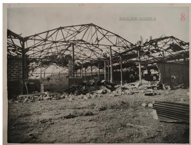
Façade Nord Bâtiment B - Photo extraite des dossiers de dommages de guerre - 1948 (AD Rhône) Phot. Alice Giacovelli IVR84_20226900434NUC
