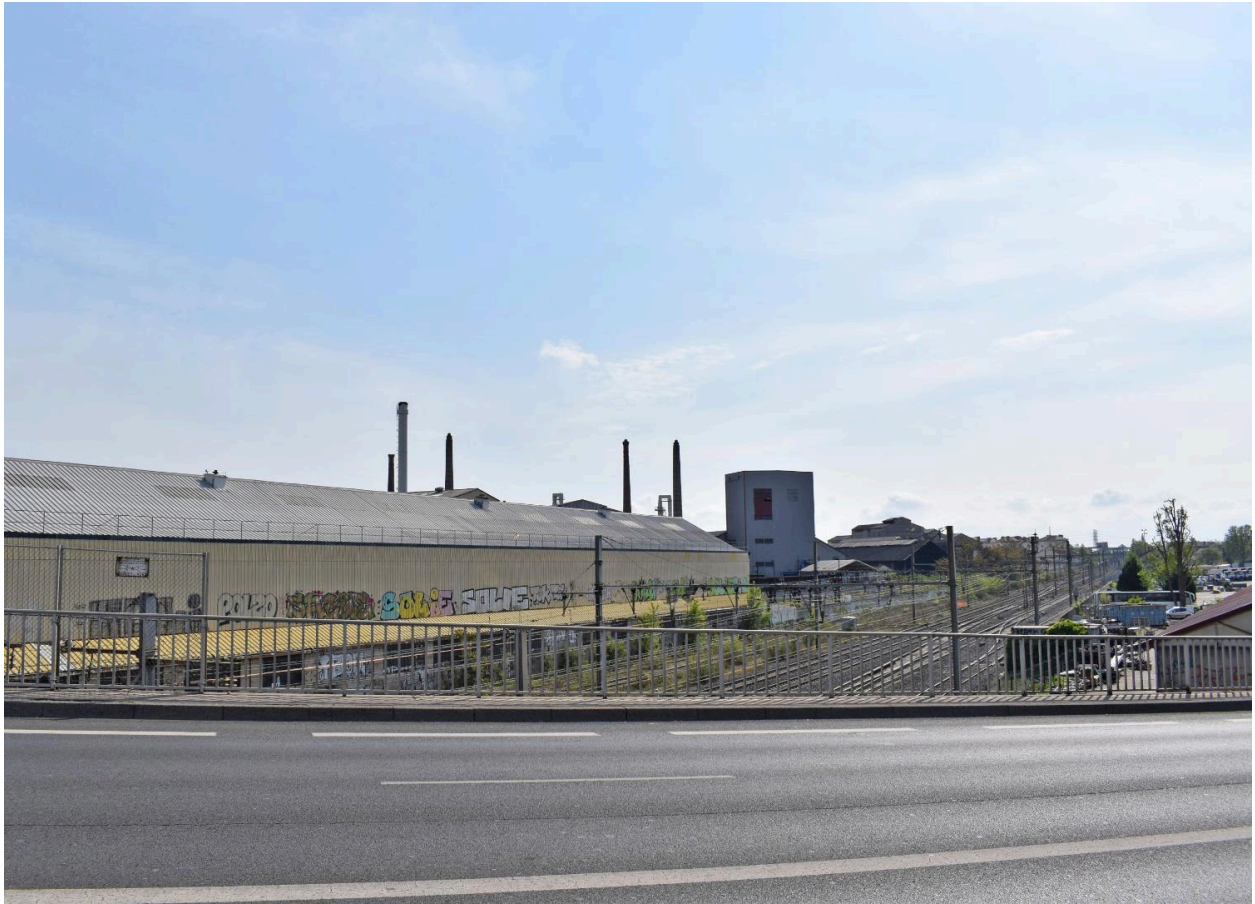
Aciéries de Longwy en 2022 vues depuis l'autopont
