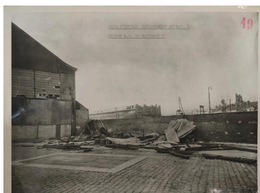
Cour d'entrée, emplacement du bâtiment E et pignon N.O. du bâtiment D - Photo extraite des dossiers de dommages de guerre - 1948 (AD Rhône) Phot. Alice Giacovelli IVR84_20226900437NUC
