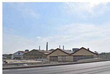
Aciéries de Longwy en 2022 vues depuis l'autopont Phot. Nadine Halitim-Dubois IVR84_20226900576NUCA
