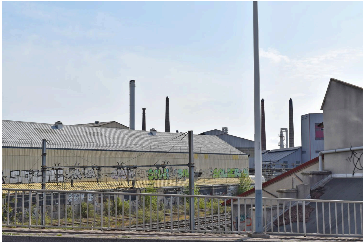
Aciéries de Longwy en 2022 vues depuis l'autopont
