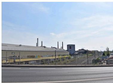
Aciéries de Longwy en 2022 vues depuis l'autopont Phot. Nadine Halitim-Dubois IVR84_20226900587NUCA
