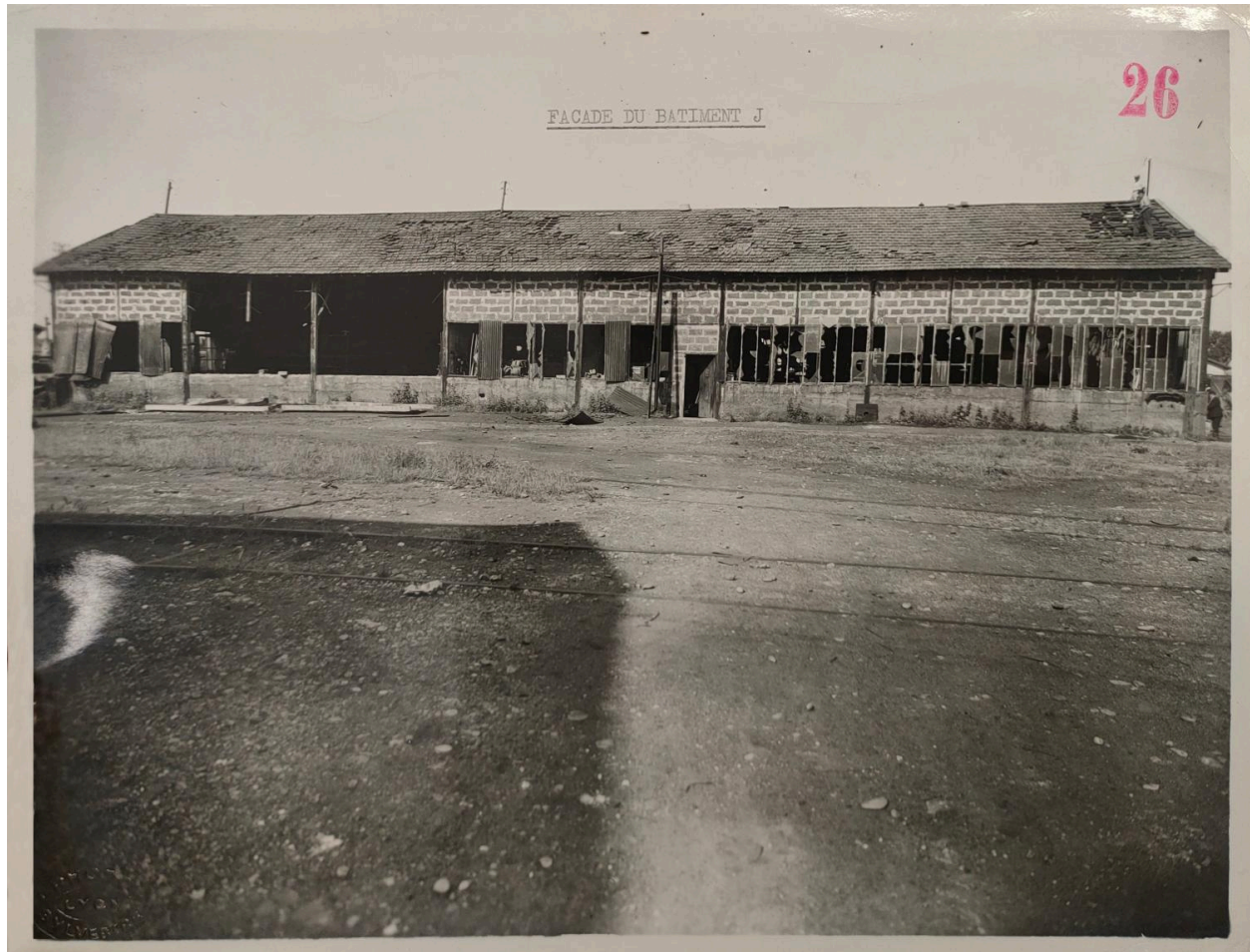
Façade Bâtiment J - Photo extraite des dossiers de dommages de guerre - 1948 (AD Rhône)
