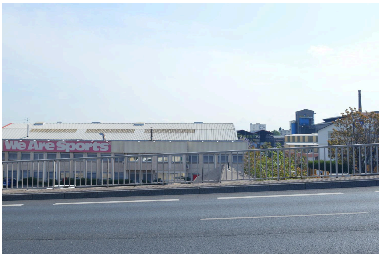
Aciéries de Longwy en 2022 vues depuis l'autopont
