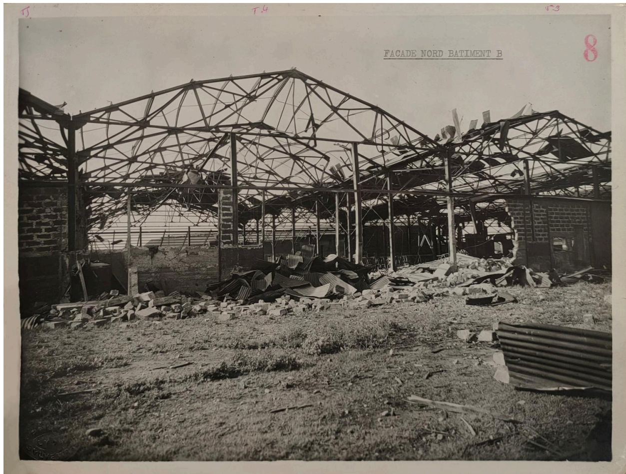
Façade Nord Bâtiment B - Photo extraite des dossiers de dommages de guerre - 1948 (AD Rhône)
