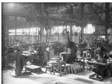
Aciéries de Longwy - Atelier de Vénissieux (?) - (BML P0546 S 1373) Phot. Alice Giacovelli IVR84_20226900087NUC
