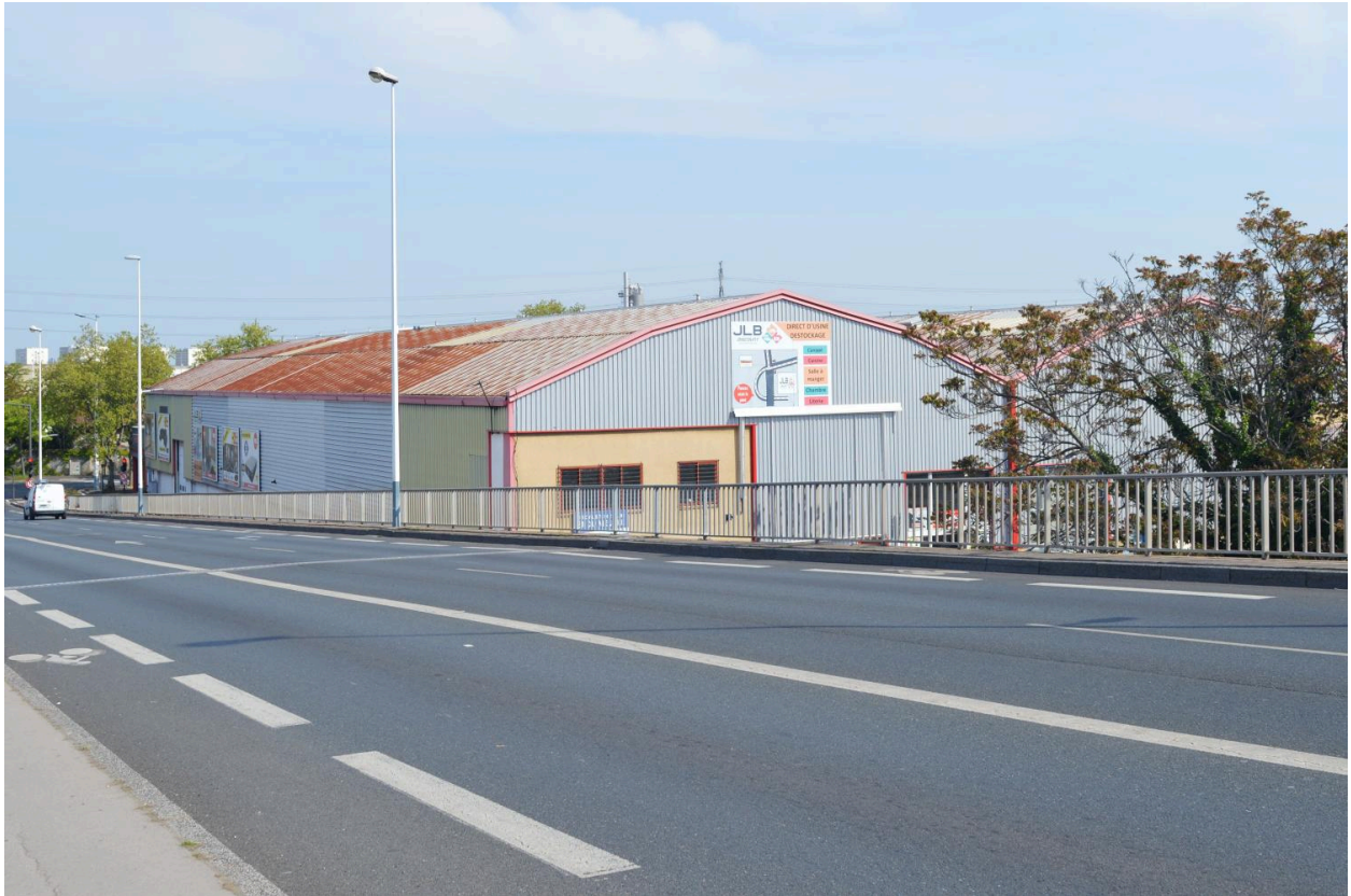
Aciéries de Longwy en 2022 vues depuis l'autopont
