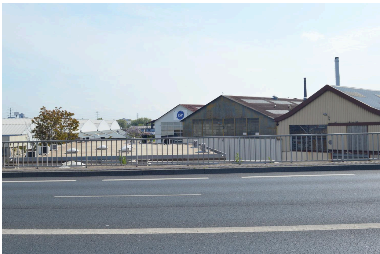
Aciéries de Longwy en 2022 vues depuis l'autopont
