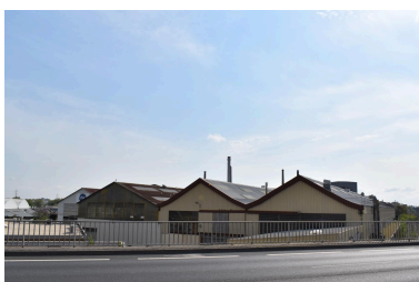
Aciéries de Longwy en 2022 vues depuis l'autopont Phot. Nadine Halitim-Dubois IVR84_20226900583NUCA
