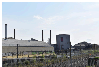
Aciéries de Longwy en 2022 vues depuis l'autopont Phot. Nadine Halitim-Dubois IVR84_20226900588NUCA
