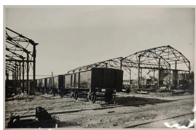
Halles endommagées - Photo extraite des dossiers de dommages de guerre - 1948 (AD Rhône) Phot. Alice Giacovelli IVR84_20226900445NUC
