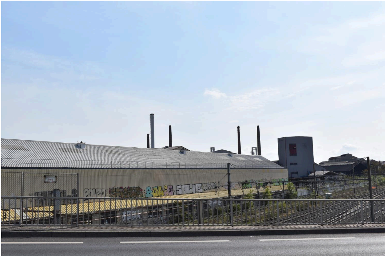
Aciéries de Longwy en 2022 vues depuis l'autopont
