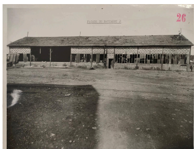
Façade Bâtiment J - Photo extraite des dossiers de dommages de guerre - 1948 (AD Rhône) Phot. Alice Giacovelli IVR84_20226900440NUC
