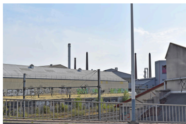
Aciéries de Longwy en 2022 vues depuis l'autopont Phot. Nadine Halitim-Dubois IVR84_20226900589NUCA
