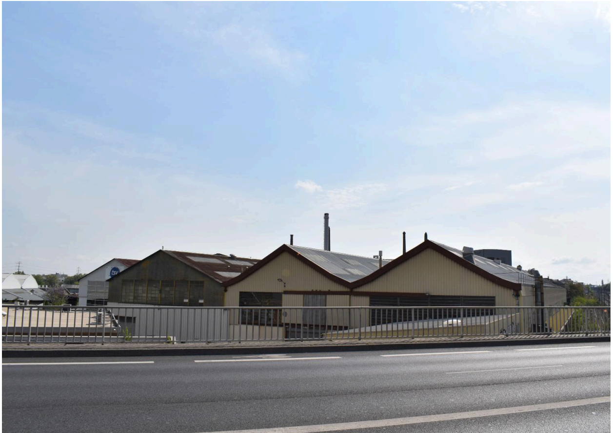
Aciéries de Longwy en 2022 vues depuis l'autopont
