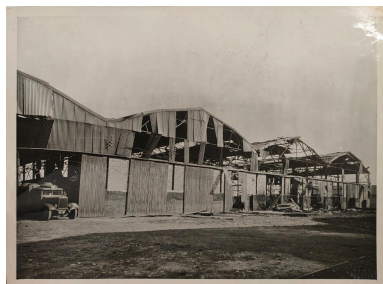
Façade Sud bâtiment A - Photo extraite des dossiers de dommages de guerre - 1948 (AD Rhône) Phot. Alice Giacovelli IVR84_20226900442NUC
