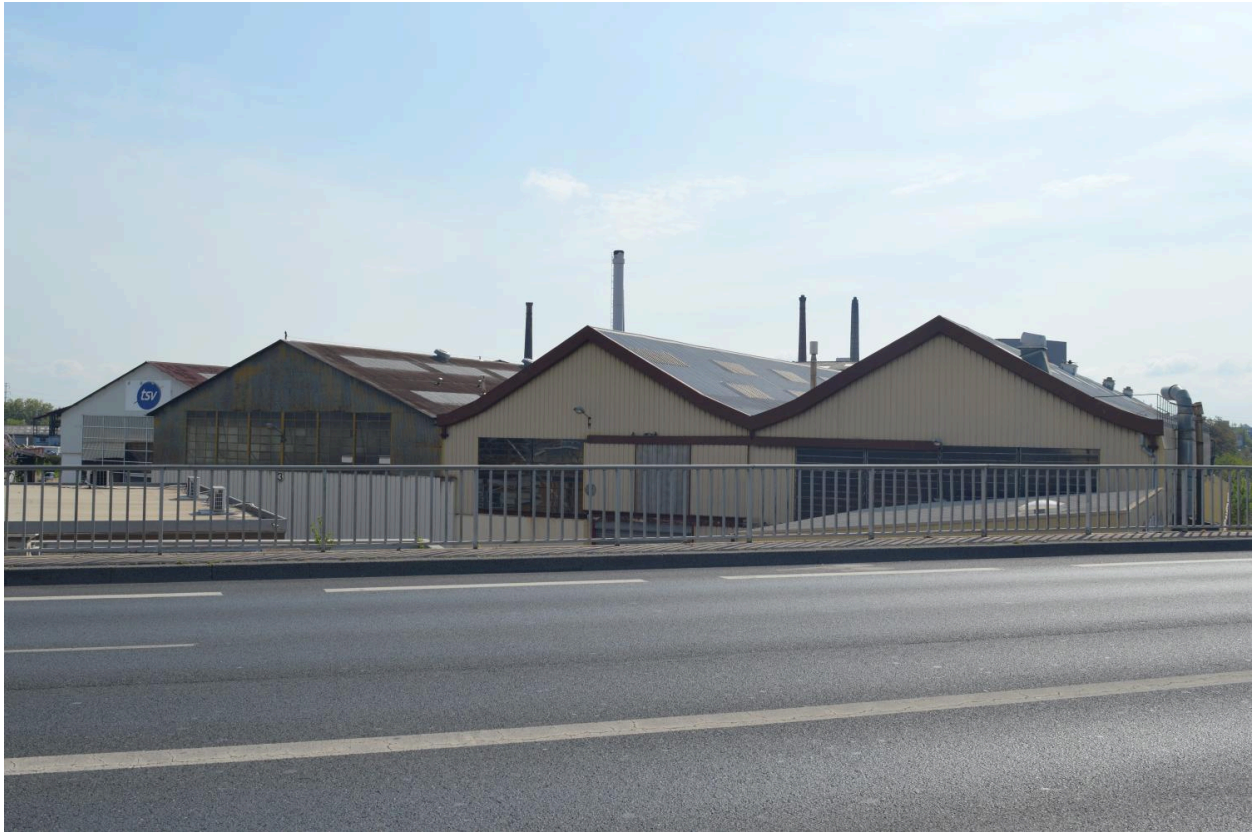
Aciéries de Longwy en 2022 vues depuis l'autopont
