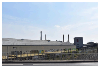
Aciéries de Longwy en 2022 vues depuis l'autopont Phot. Nadine Halitim-Dubois IVR84_20226900585NUCA
