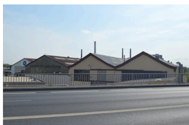
Aciéries de Longwy en 2022 vues depuis l'autopont Phot. Nadine Halitim-Dubois IVR84_20226900577NUCA
