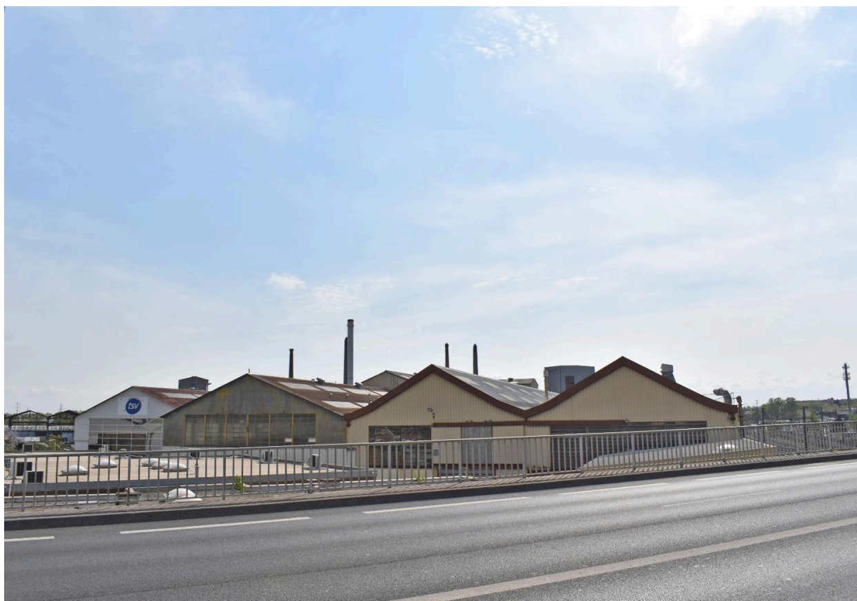
Aciéries de Longwy en 2022 vues depuis l'autopont
