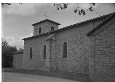
Vue partielle de l'élévation sud. Phot. Jean-Marie Refflé IVR82_19920100386P
