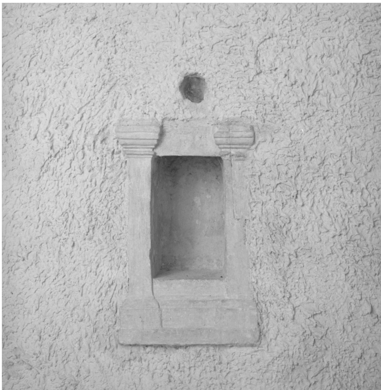
Niche dans le mur sud.
