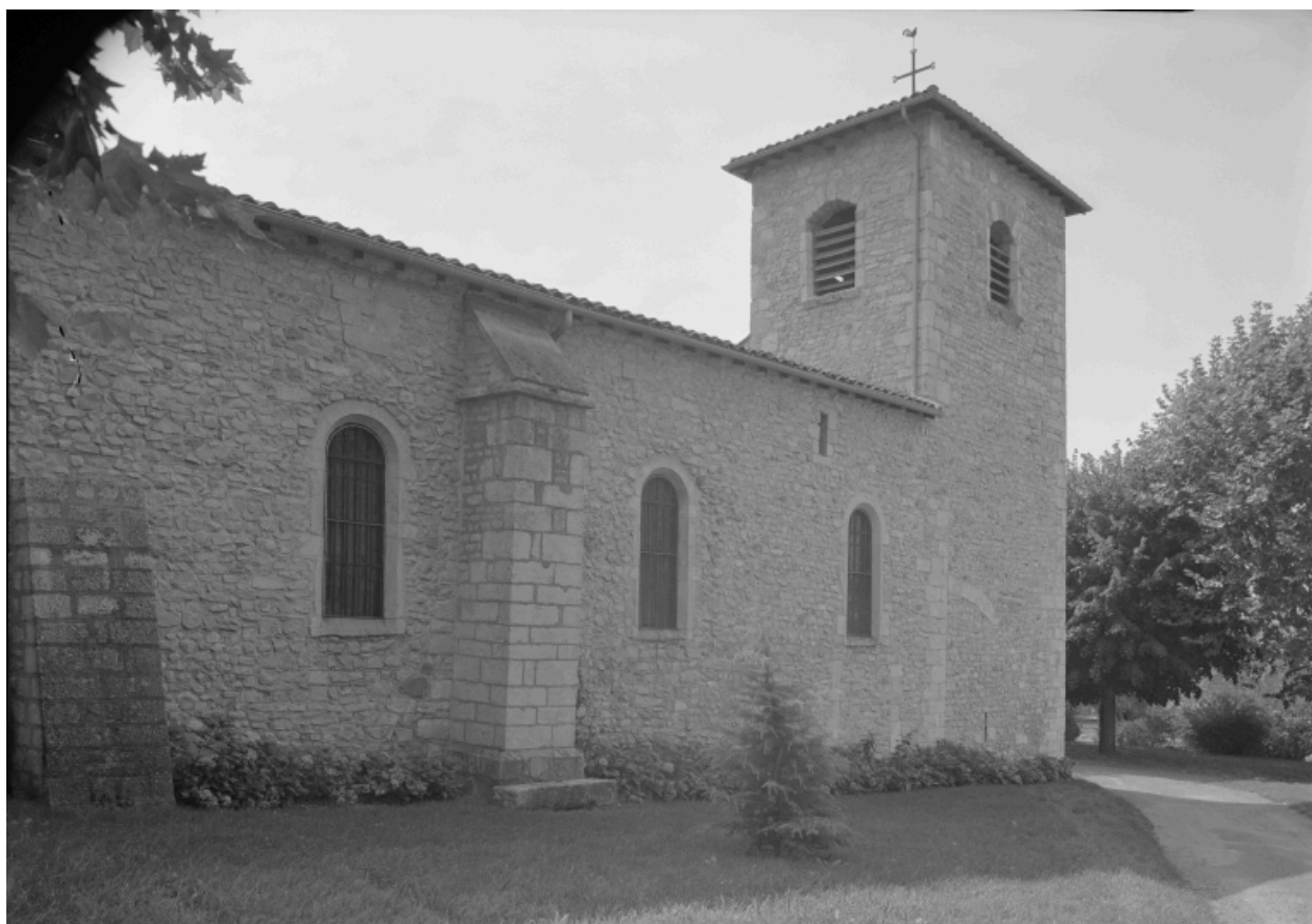
Vue partielle de l'élévation nord.
