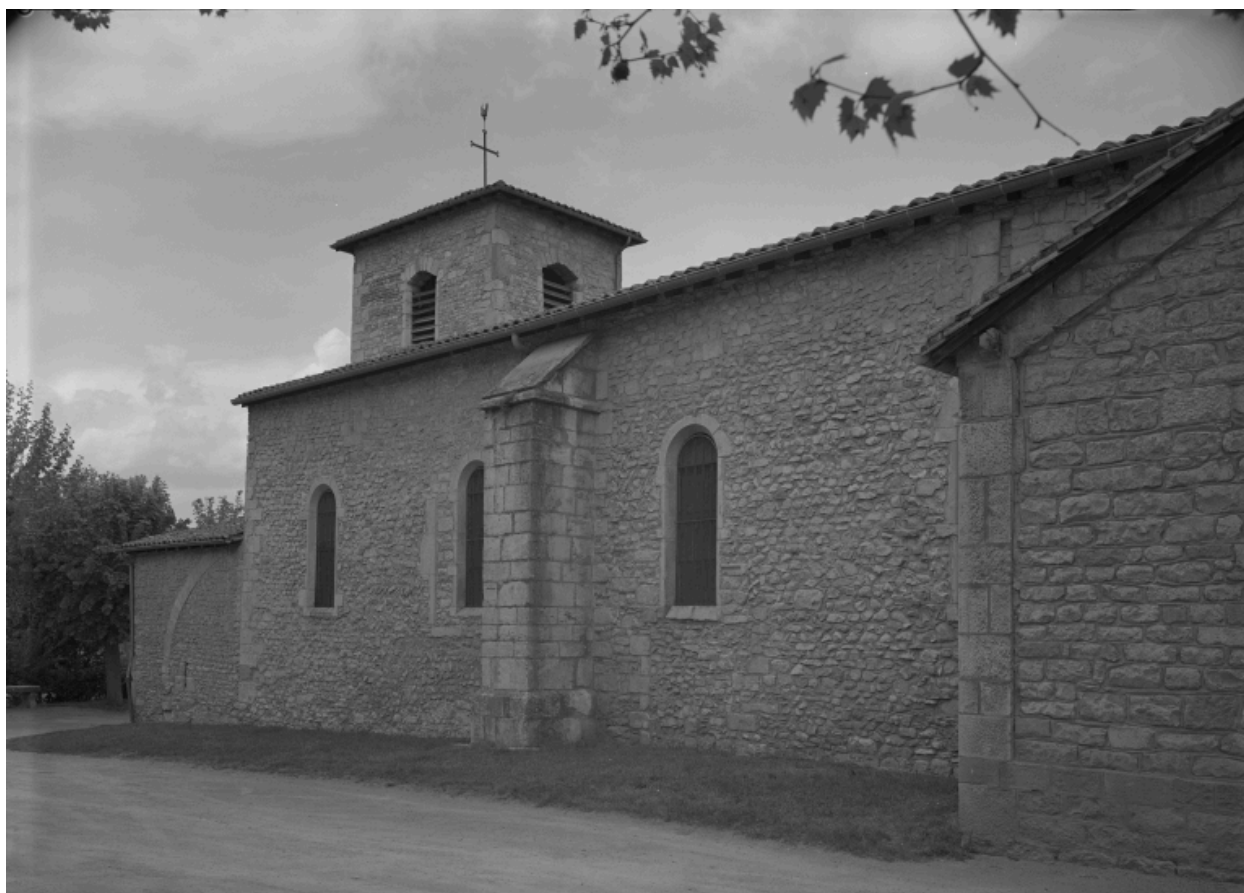
Vue partielle de l'élévation sud.
