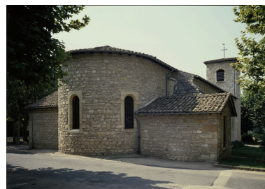
Vue d'ensemble du chevet. Phot. Jean-Marie Refflé IVR82_19870100338PA
