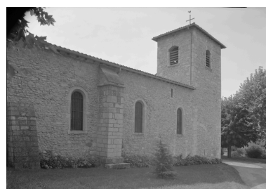
Vue partielle de l'élévation nord. Phot. Jean-Marie Refflé IVR82_19870100274P
