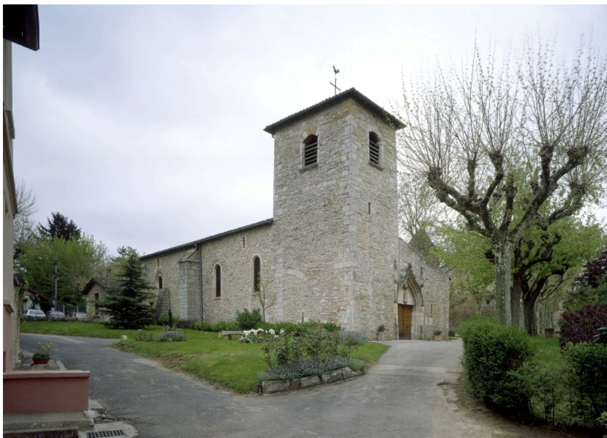
Vue prise du nord-ouest.
