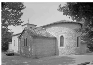
Vue d'ensemble prise du sud-est. Phot. Jean-Marie Refflé IVR82_19870100273P
