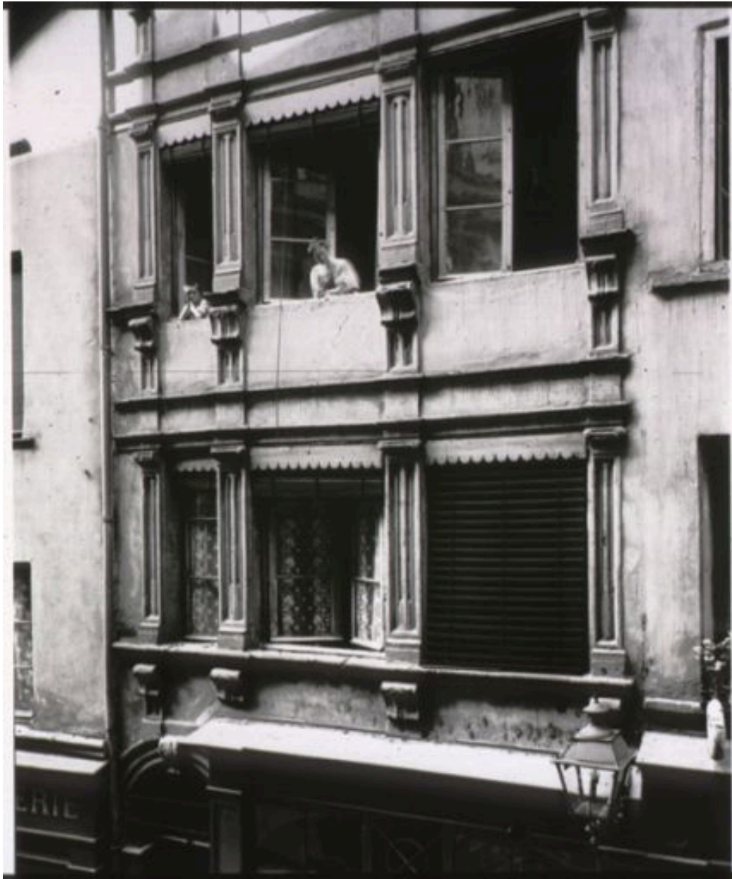
6, rue Mercière [détail de la façade], fotogr. par Jules Sylvestre, ca 1902
