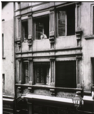
6, rue Mercière [détail de la façade], fotogr. par Jules Sylvestre, ca 1902 Phot. Repro. BM Lyon D. Nicolle IVR82_20056900387NUCB
