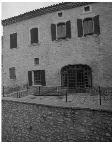
Façade sur terrasse au-dessus de la rue, vue partielle.
