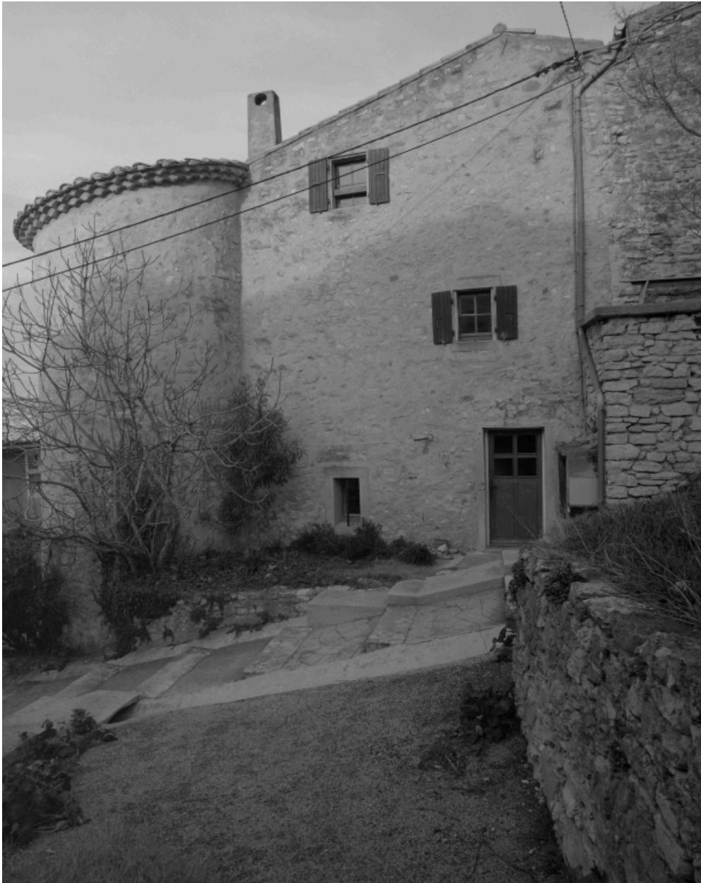
Tour d'angle et élévation latérale sur la rue montant à l'église.
