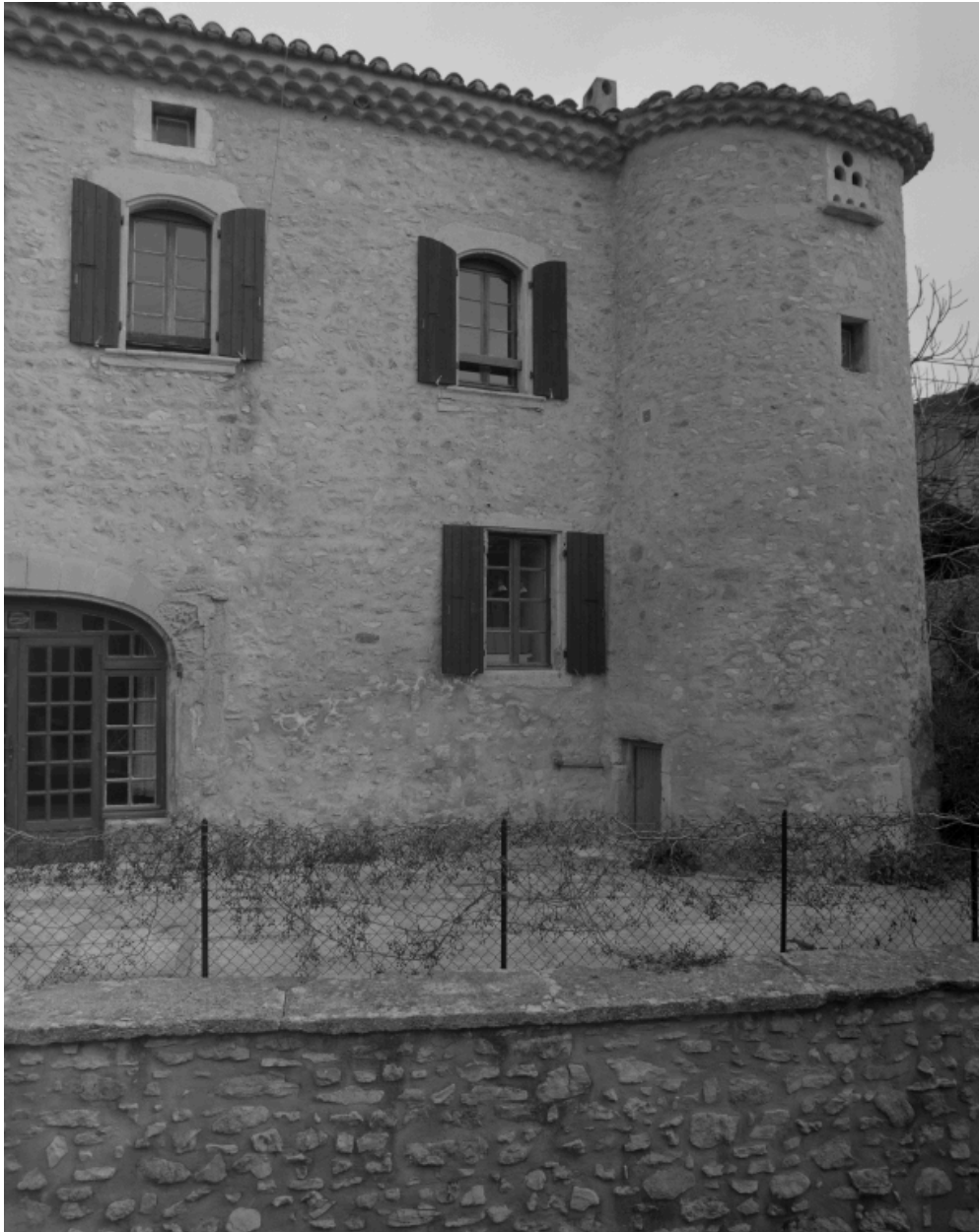
Façade, partie droite : élévation pratiquée dans la courtine, avec tour de fortification sur l'angle.
