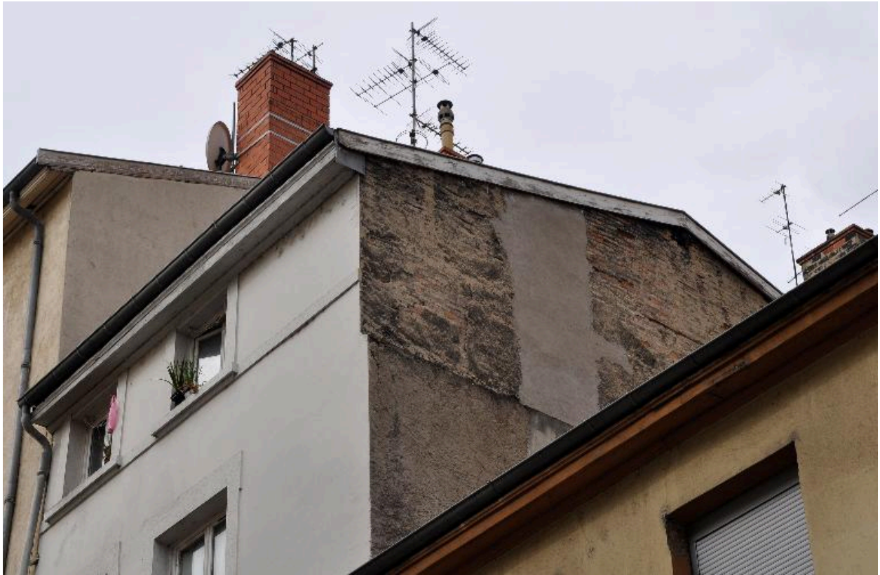
Vue rapprochée du mur pignon, montrant la surélévation en briques
