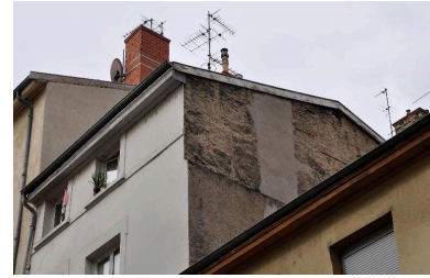
Vue rapprochée du mur pignon, montrant la surélévation en briques Phot. Catherine Guégan IVR84_20166900673NUCA
