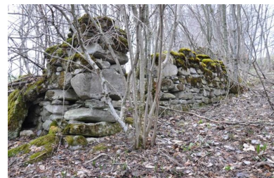
Vestiges de l'un des moulins. Phot. Clara Bérelle IVR84_20197300089NUCA
