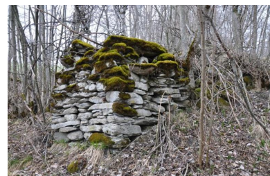
Muret de pierre soutenant la dérivation immédiatement en amont des vestiges du moulin. Phot. Clara Bérelle IVR84_20197300090NUCA
