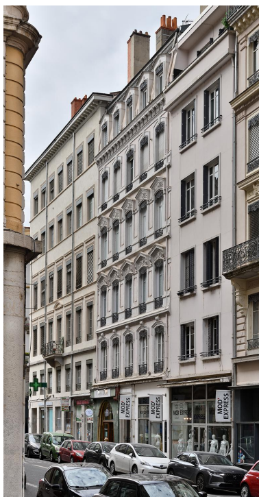
Vue générale, avec au premier plan, l'immeuble adressé au n° 54 Phot. Thierry Leroy IVR84_20256900937NUCAQ
