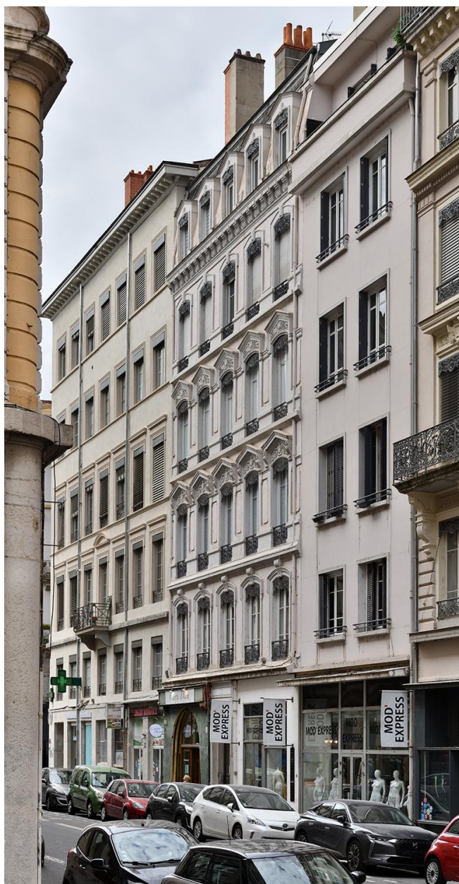
Vue générale, avec au premier plan, l'immeuble adressé au n° 54
