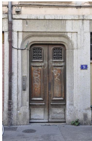
Porte d'entrée Phot. Magali Delavenne IVR84_20166902142NUCA
