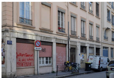
Anciennes boutiques au rez-de-chaussée Phot. Magali Delavenne IVR84_20166902141NUCA
