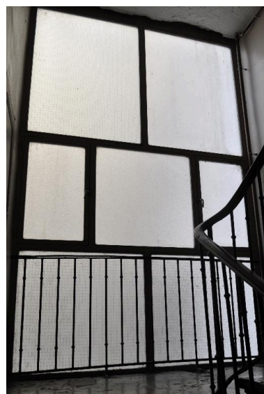
Vitrage fermant la cage d'escalier Phot. Magali Delavenne IVR84_20166902145NUCA
