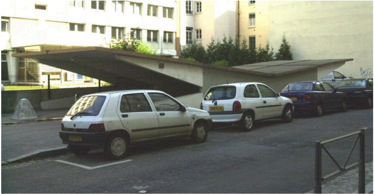
Détail de l'entrée des garages, rue Quivogne
