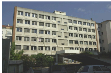
Vue générale rue Quivogne Phot. François Blanchetière IVR82_20016901999NUCA
