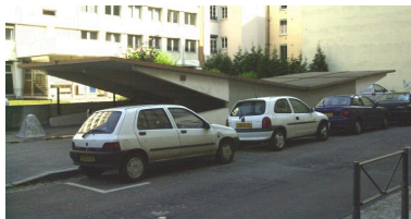
Détail de l'entrée des garages, rue Quivogne Phot. François Blanchetière IVR82_20016902000NUCA
