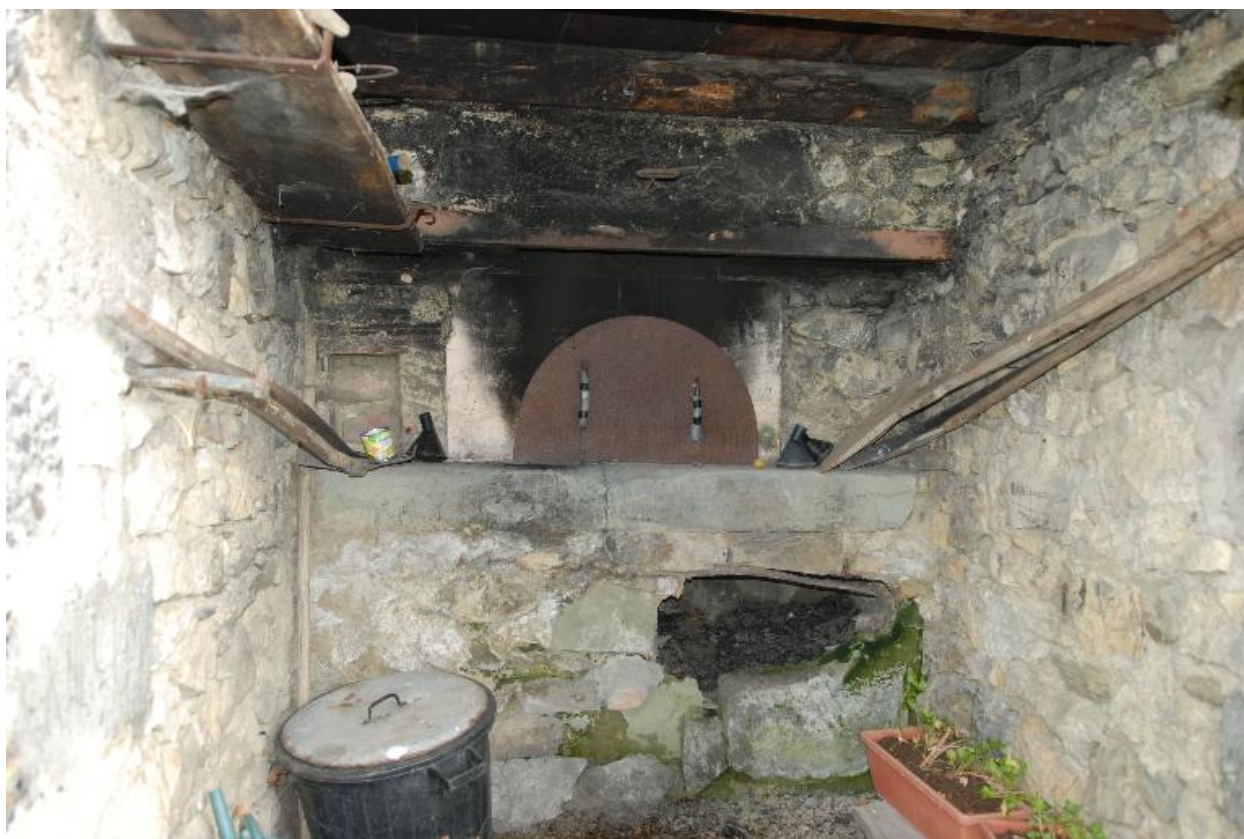
Vue intérieure du four à pain.
