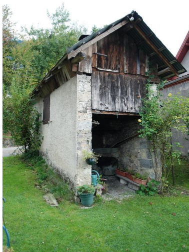
Vue d'ensemble du four à pain. Phot. Thierry Monnet IVR84_20177300715NUCA
