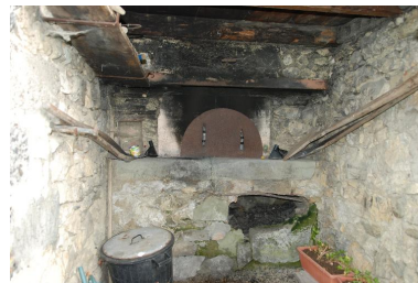
Vue intérieure du four à pain. Phot. Thierry Monnet IVR84_20177300716NUCA
