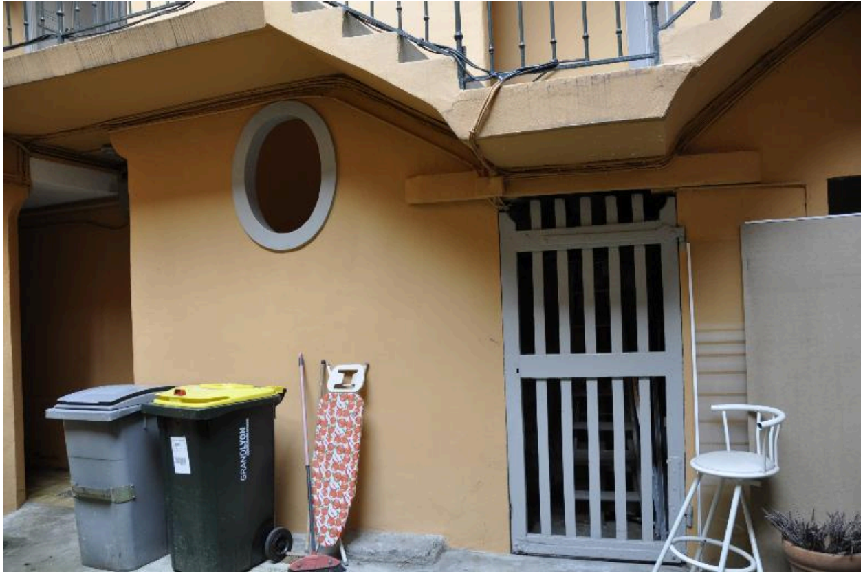
Vue du soubassement de l'escalier depuis la cour
