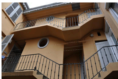
Vue de l'escalier depuis la cour Phot. Nadine Halitim-Dubois IVR82_20146900368NUCA
