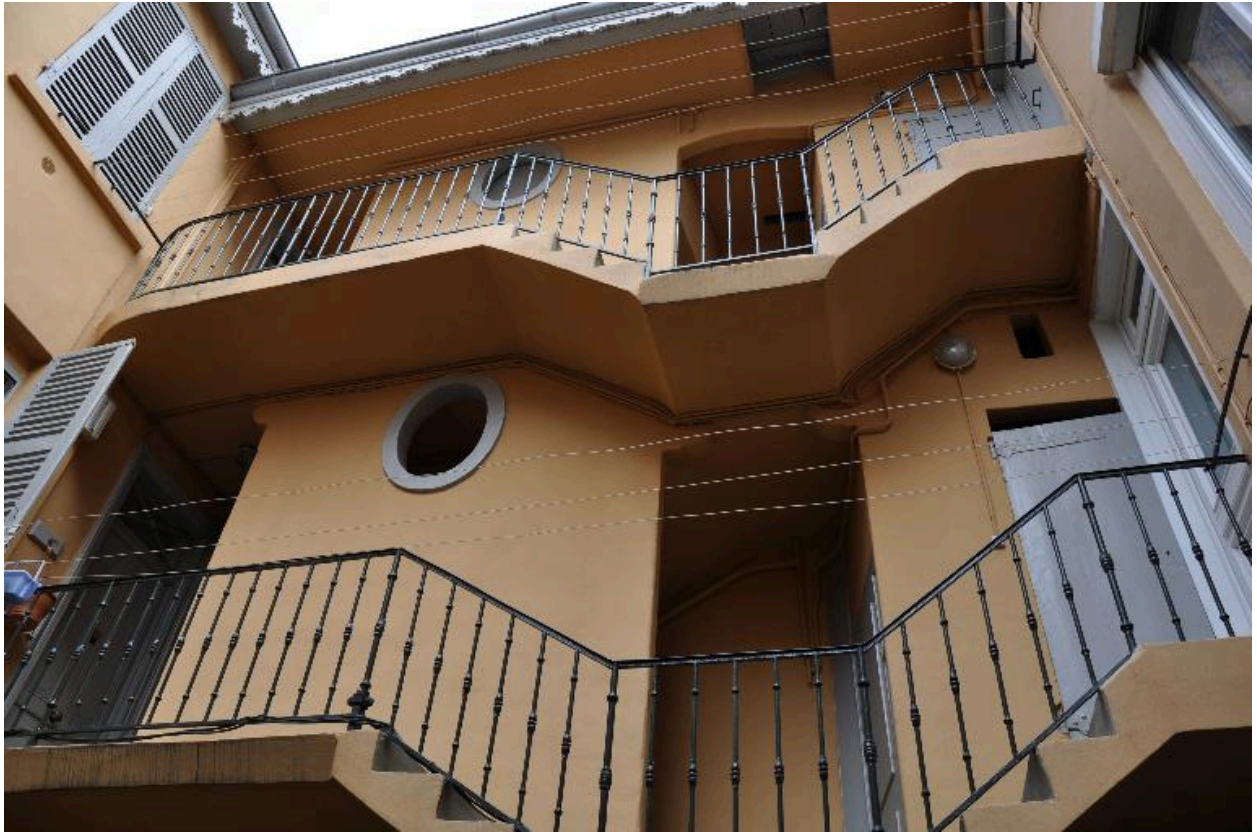
Vue de l'escalier depuis la cour
