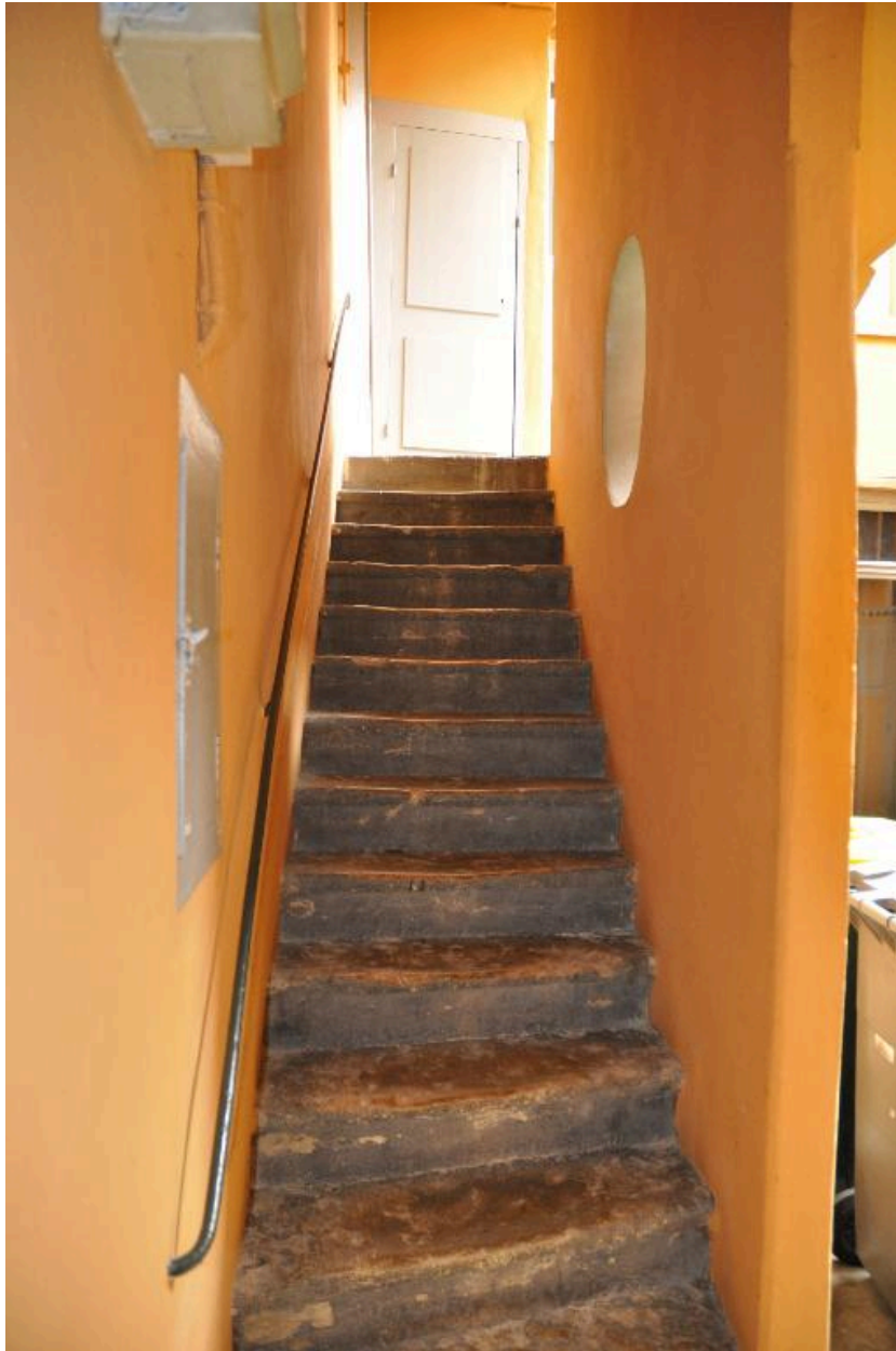
Vue de la première volée de l'escalier
