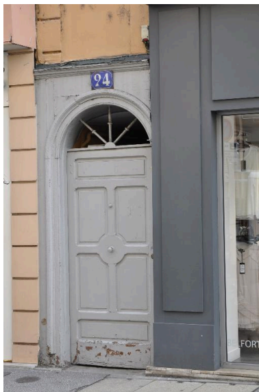
Vue de la porte Phot. Nadine Halitim-Dubois IVR82_20146900375NUCA
