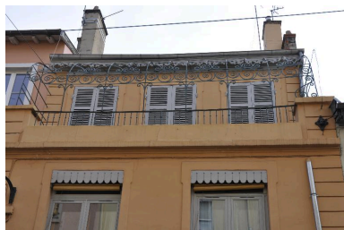
Vue ouest de l'étage en terrasse Phot. Nadine Halitim-Dubois IVR82_20146900374NUCA
