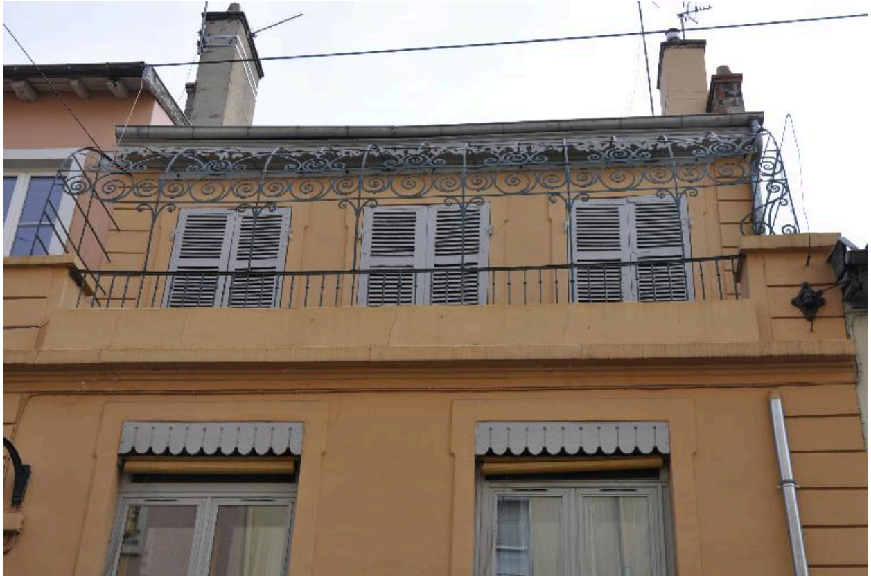
Vue ouest de l'étage en terrasse
