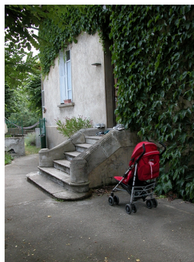
Détail du perron. Phot. Thierry Monnet IVR82_20134200933NUCA
