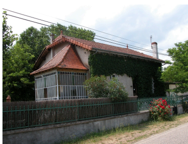
Vue générale. Phot. Thierry Monnet IVR82_20134200932NUCA
