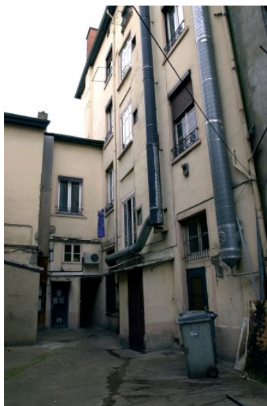
Elévation sur cour Phot. Maryannick Chalabi IVR82_20016900218NUCA
