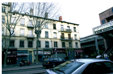
Vue générale, cours Charlemagne Phot. Maryannick Chalabi IVR82_20016900213NUCA
