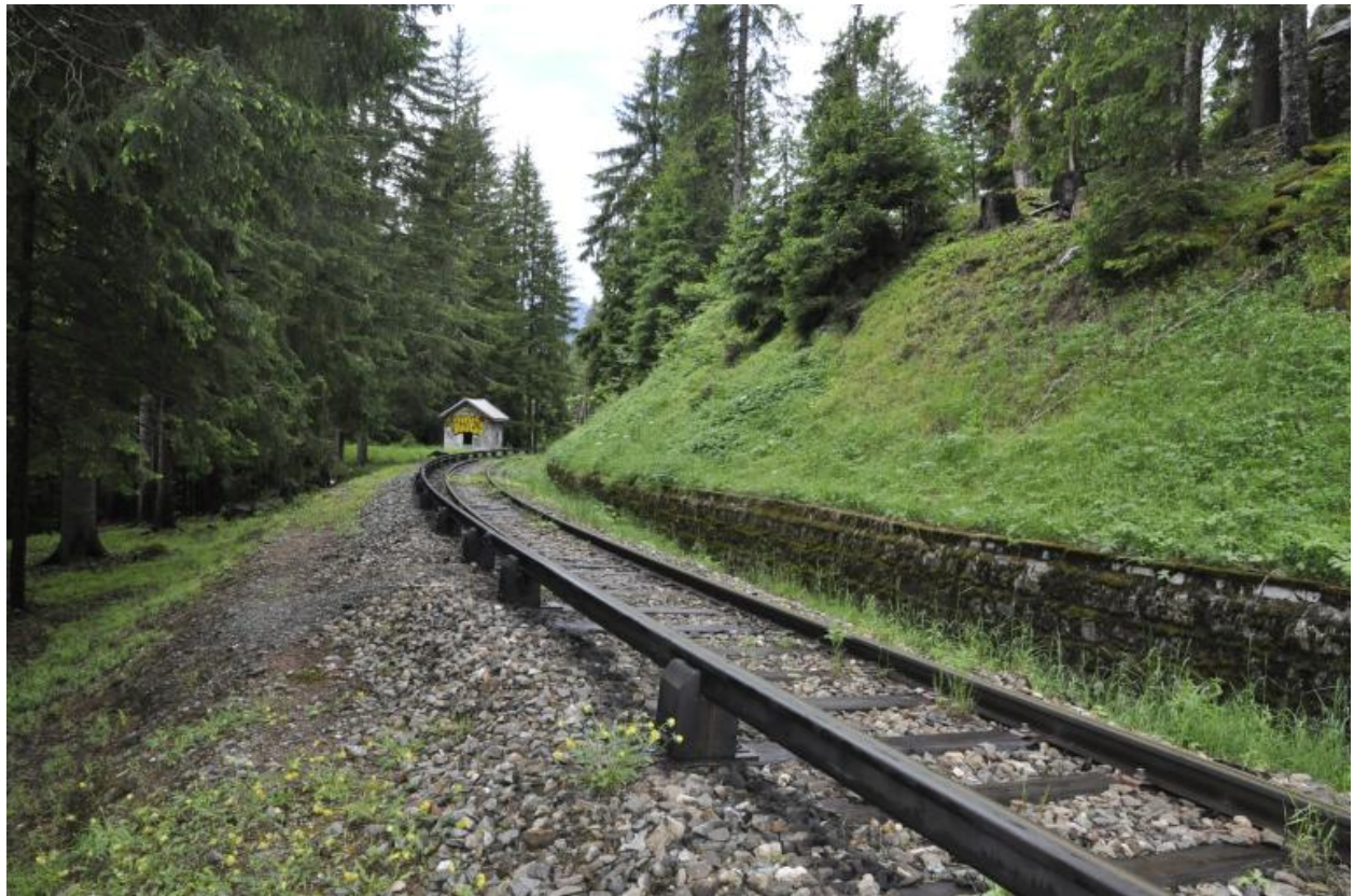
Voie ferroviaire passant sur l'aqueduc allant en direction de la halte de La Joux
