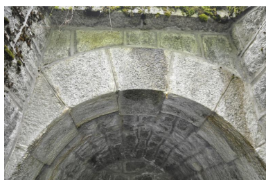
Détail du bandeau et de la clé de voûte de la face sud-est Phot. Samir Mahfoudi IVR84_20207401168NUCA
