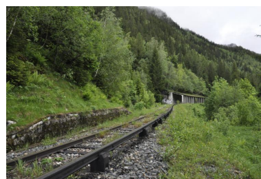
Voie ferroviaire passant sur l'aqueduc allant en direction de la halte des Tines Phot. Samir Mahfoudi IVR84_20207401170NUCA
