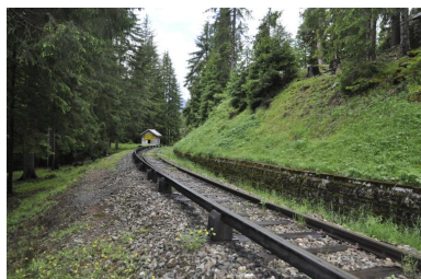
Voie ferroviaire passant sur l'aqueduc allant en direction de la halte de La Joux Phot. Samir Mahfoudi IVR84_20207401171NUCA
