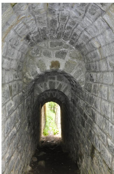
Voûte en berceau plein-cintre appareillée en rouleaux à ressauts Phot. Samir Mahfoudi IVR84_20207401169NUCA
