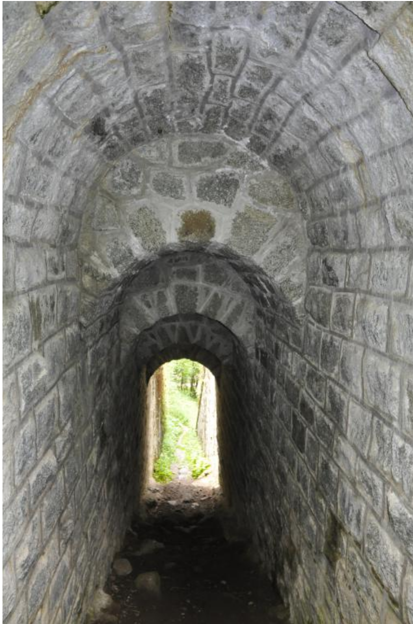
Voûte en berceau plein-cintre appareillée en rouleaux à ressauts
