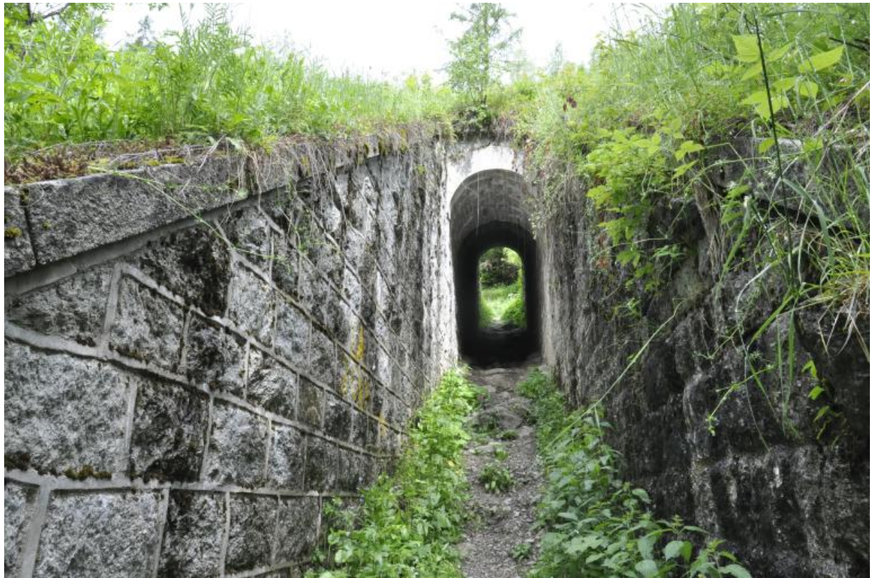
Vue de la face sud-est de l'aqueduc
