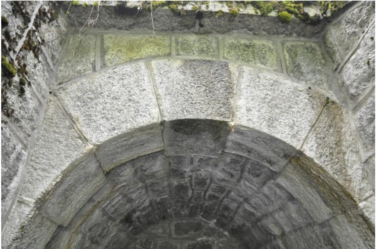
Détail du bandeau et de la clé de voûte de la face sud-est
