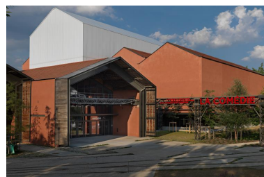
Détail des halles extérieures Phot. Thierry Leroy IVR84_20184200073NUCAQ
