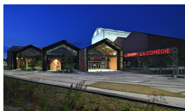
Vue d'ensemble extérieur nuit Phot. Thierry Leroy IVR84_20184200093NUCAQ
