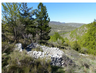
Vue d'ensemble prise du sud. Phot. Alexeï Laurent IVR84_20162600188NUCA
