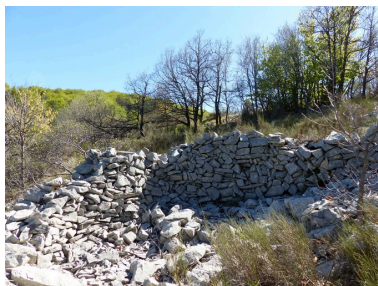
Vue de volume prise du nord-est. Phot. Alexeï Laurent IVR84_20162600192NUCA
