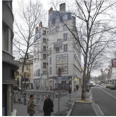
Vue d'ensemble depuis le nord-est Phot. Eric Dessert IVR82_20056900659NUCA
