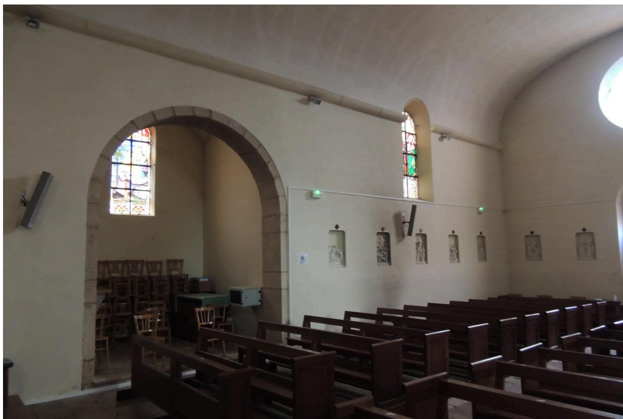
Vue intérieure, élévation sud.
