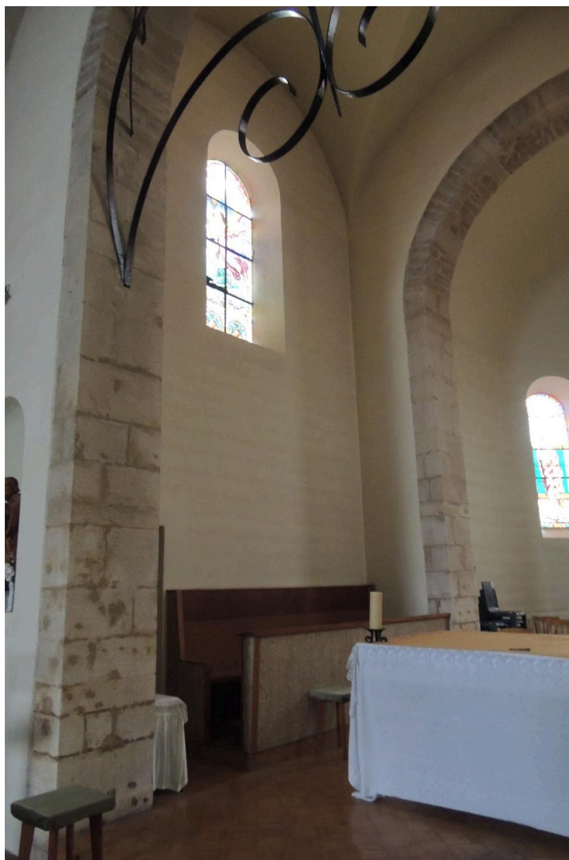
Travée de chœur, élévation nord.
