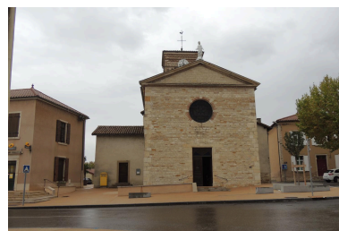
Façade occidentale. Phot. Elisabeth Dandel IVR84_20210100020NUCA
