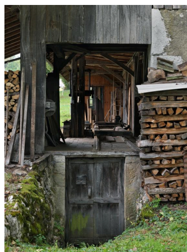
Elévation sud : lame battante, chariot et accès au sous-sol. Phot. Thierry Leroy IVR84_20167306188NUCAQ
