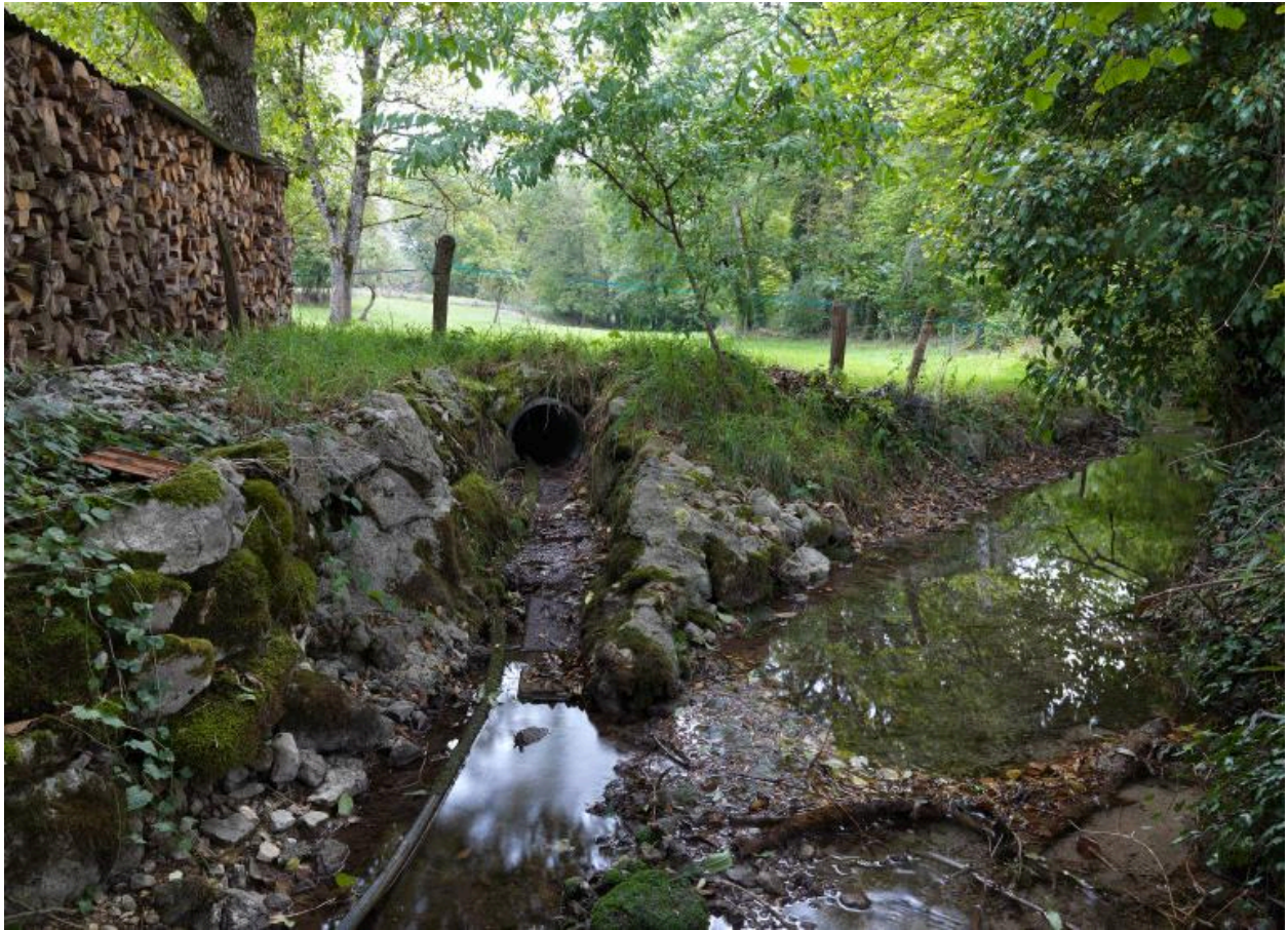
Vue du bief.
