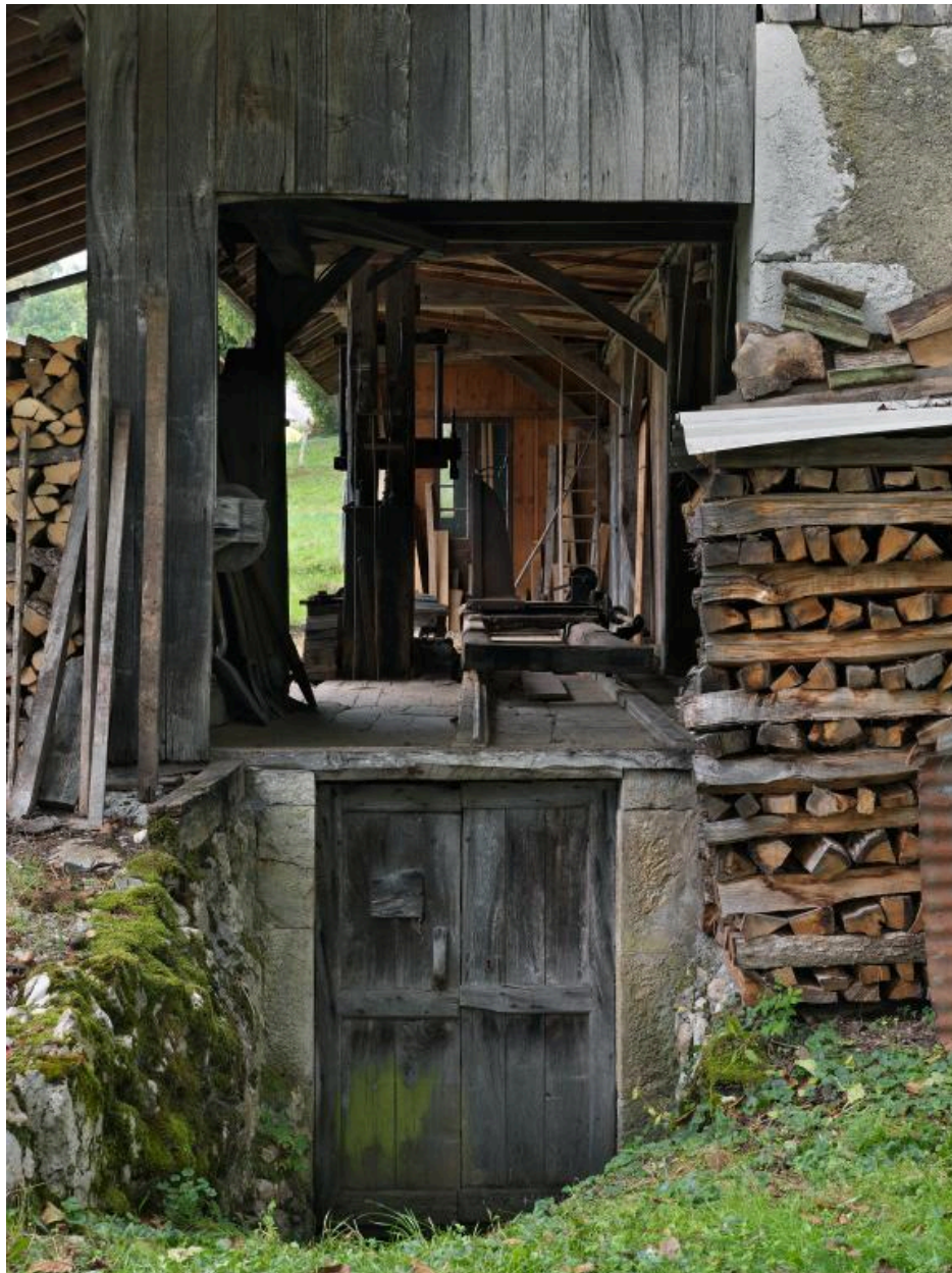
Elévation sud : lame battante, chariot et accès au sous-sol.
