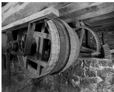
Vue intérieure du sous-sol : détail du système d'entraînement de la lame battante et du chariot. Phot. Thierry Leroy IVR84_20167306217NUCQ
