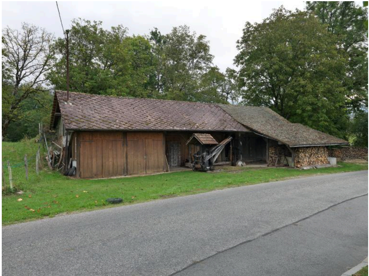
Vue de la façade ouest.
