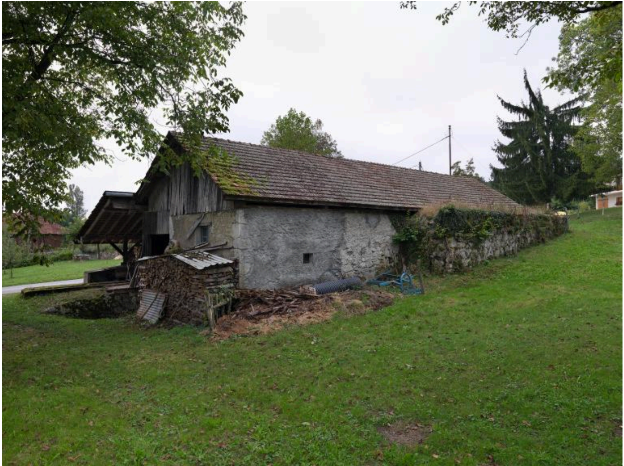
Vue de l'élévation postérieure.
