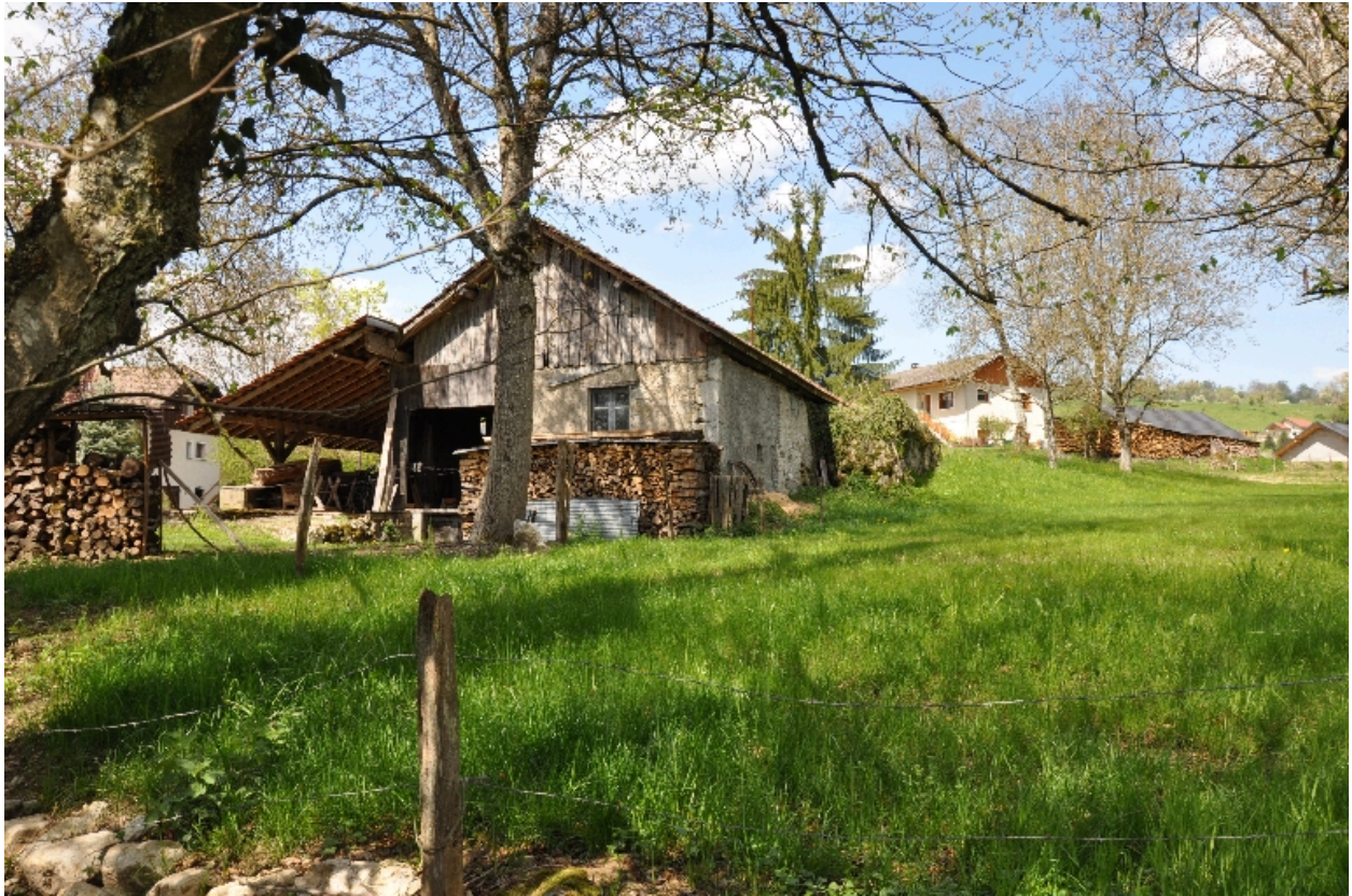
Vue depuis le sud-est.
