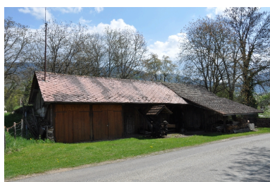
Vue de la façade ouest. Phot. Yannick Milleret IVR82_20117302304NUCA
