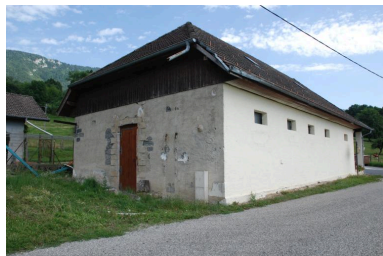
Vue d'ensemble de l'ancienne porcherie, côté nord. Phot. Thierry Monnet IVR84_20207401903NUCA
