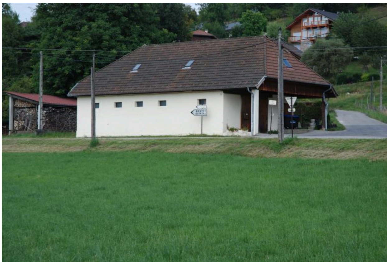
Vue d'ensemble de l'ancienne porcherie, côté sud.
