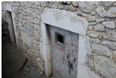
Détail des portes d'accès aux caves Phot. Thierry Monnet IVR84_20207401901NUCA
