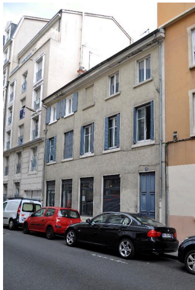
Vue générale, élévation sur rue Phot. Magali Delavenne IVR84_20176901433NUCA
