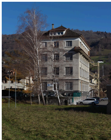
Vue d'ensemble sud de l'ancienne usine Ramel Phot. Thierry Leroy IVR82_20157402894NUCAQ
