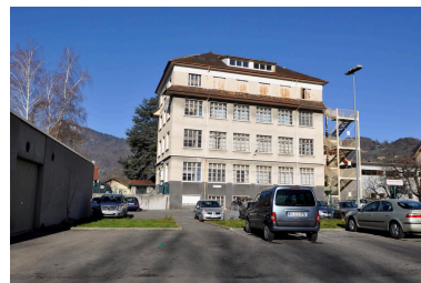
Vue de la façade sud du bâtiment principale et de l'escalier extérieur. Phot. Nadine Halitim-Dubois IVR82_20157402785NUCA
