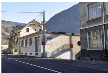
Bâtiment d'accueil en rez- de-chaussée, vue sud-ouest. Phot. Nadine Halitim-Dubois IVR82_20157402789NUCA
