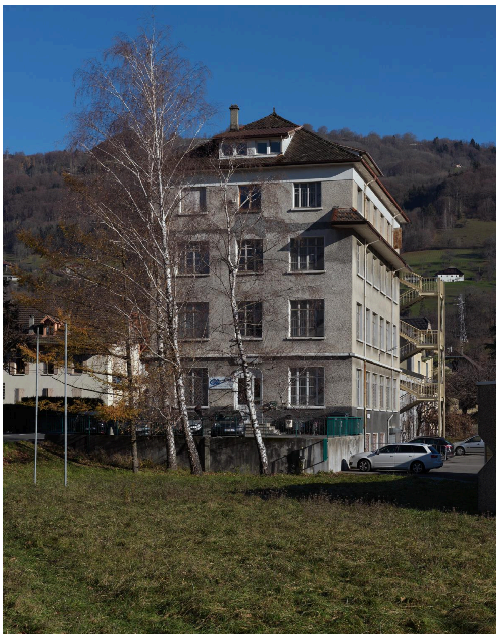
Vue d'ensemble sud de l'ancienne usine Ramel
