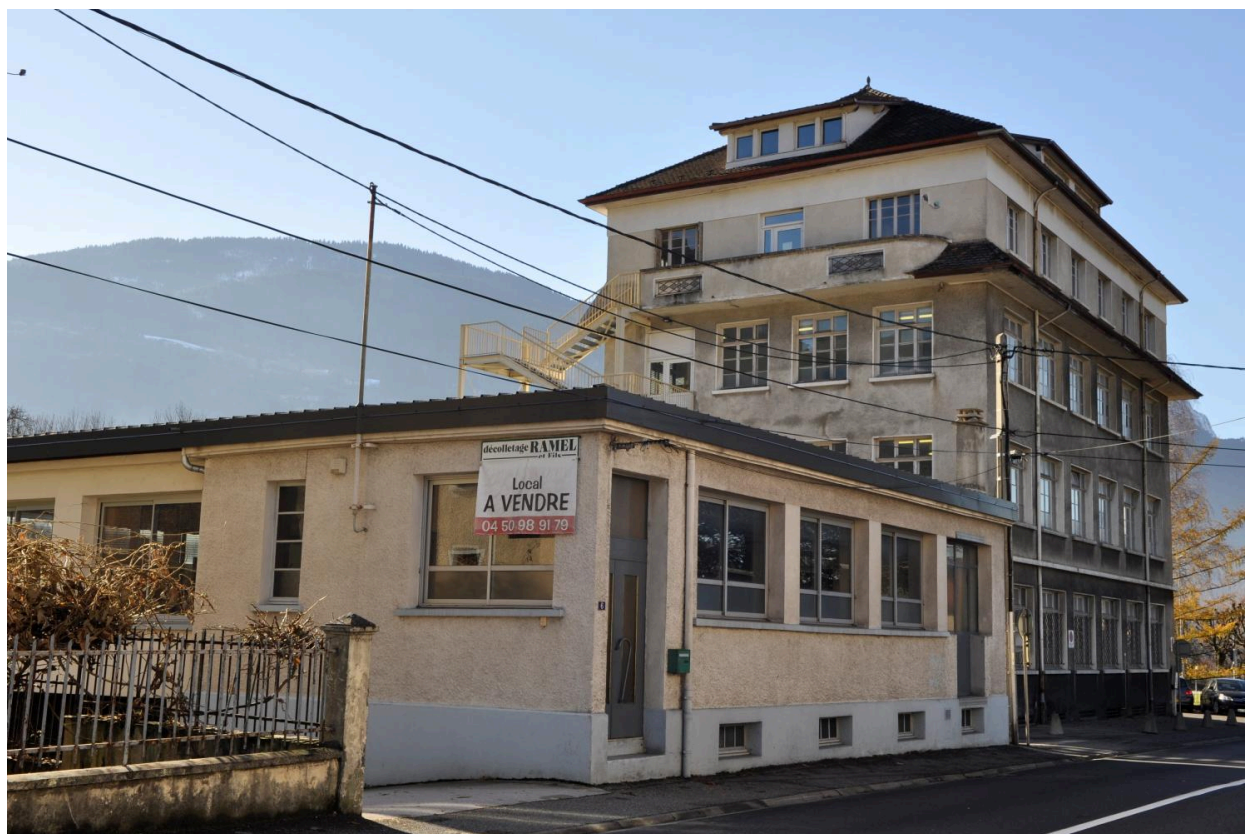
Bâtiment d'accueil en rez-de-chaussée de l'usine Ramel, vue nord-est.
