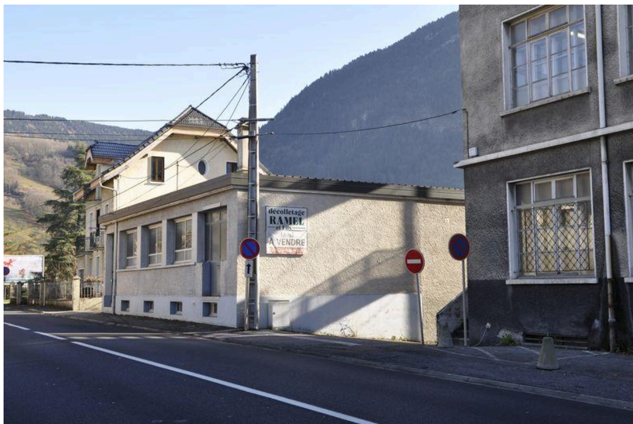
Bâtiment d'accueil en rez-de-chaussée, vue sud-ouest.
