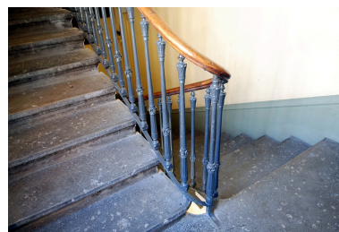
L'escalier Phot. Véronique Belle IVR82_20096904724NUCA
