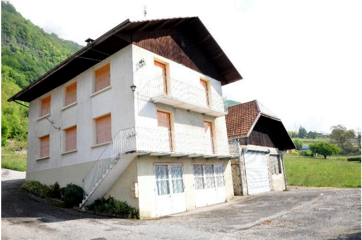
Vue du site. Façade sud.
