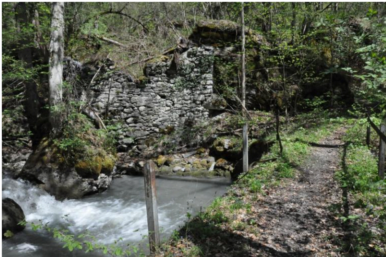
Vue du bâtiment aval implanté à proximité du pont.
