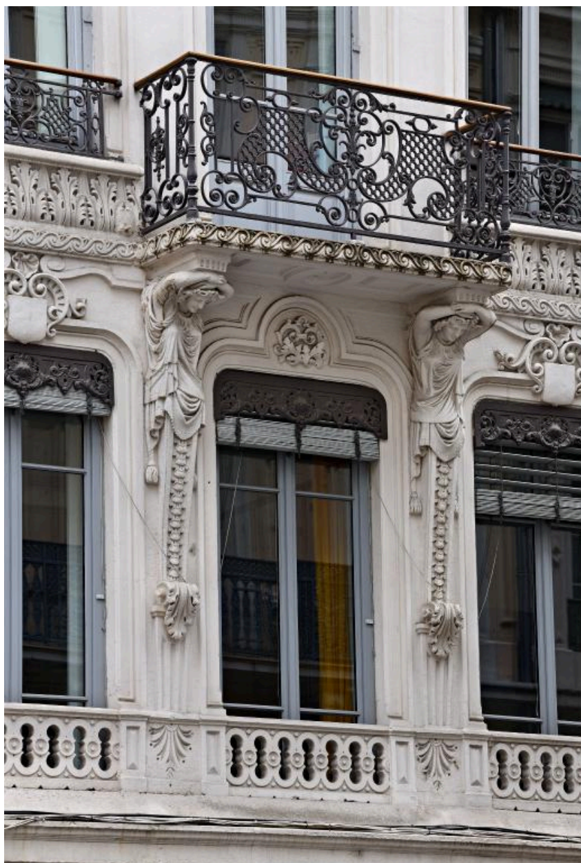
Rue de Brest : balcon et termes féminins, premier et deuxième étages carrés
