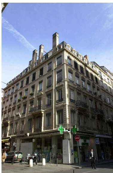
Elévations sud et est Phot. David Chevallier IVR82_20046905209NUCA
