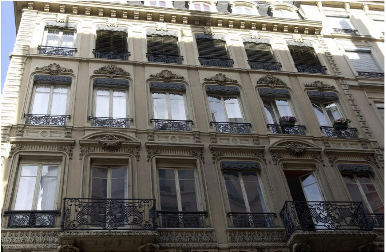
Élévation est : détail des étages carrés supérieurs
