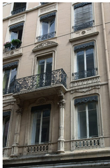
Rue Ferrandière : vue partielle de l'élévation Phot. David Chevallier IVR82_20046905262NUCA
