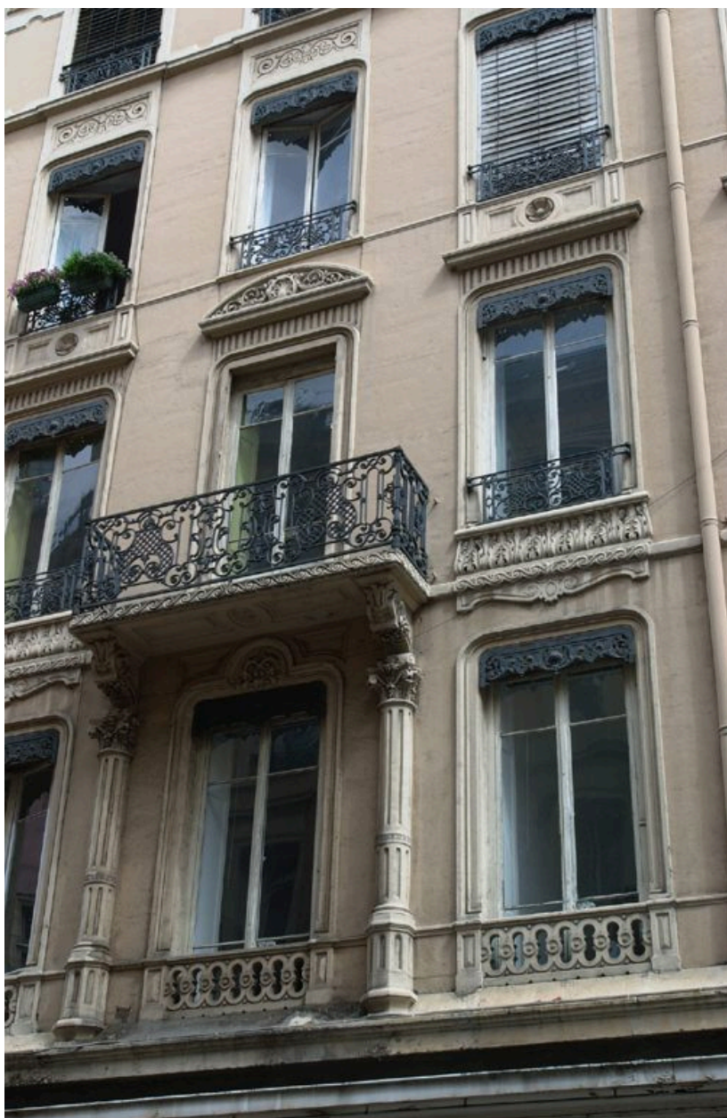
Rue Ferrandière : vue partielle de l'élévation
