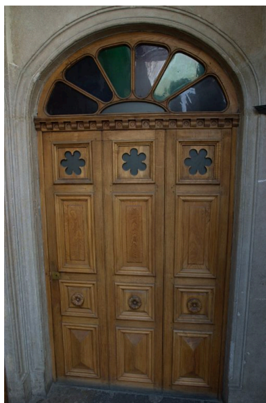
Porte palière Phot. Véronique Belle IVR82_20046905275NUCA
