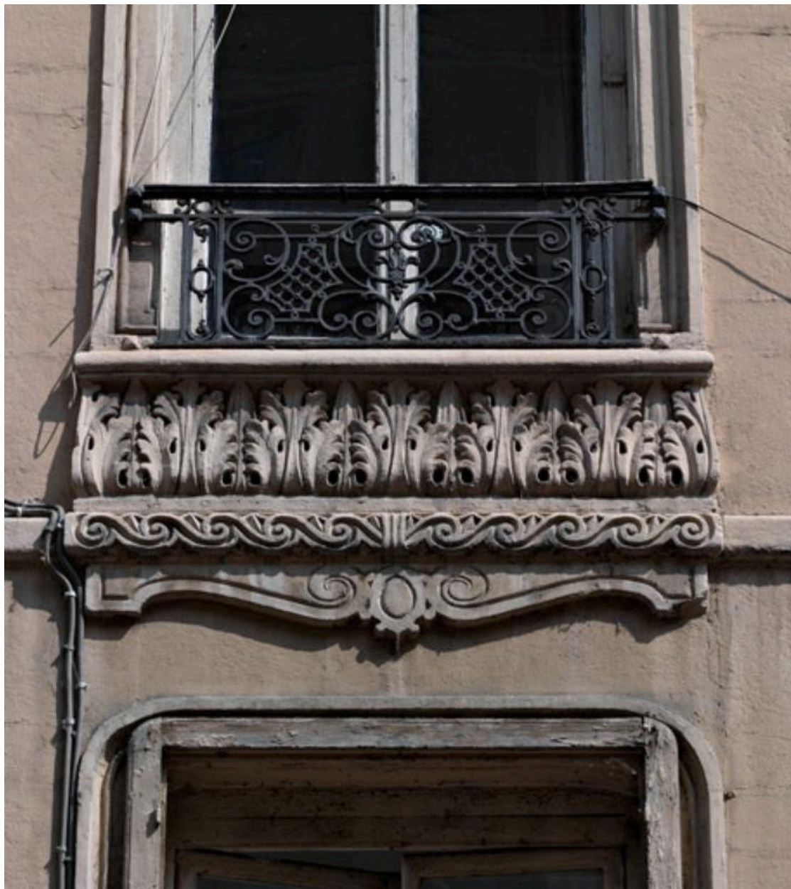
Elévations ouest et sud, deuxième étage carré : appui de fenêtre souligné d'une rangée de feuilles d'acanthé
