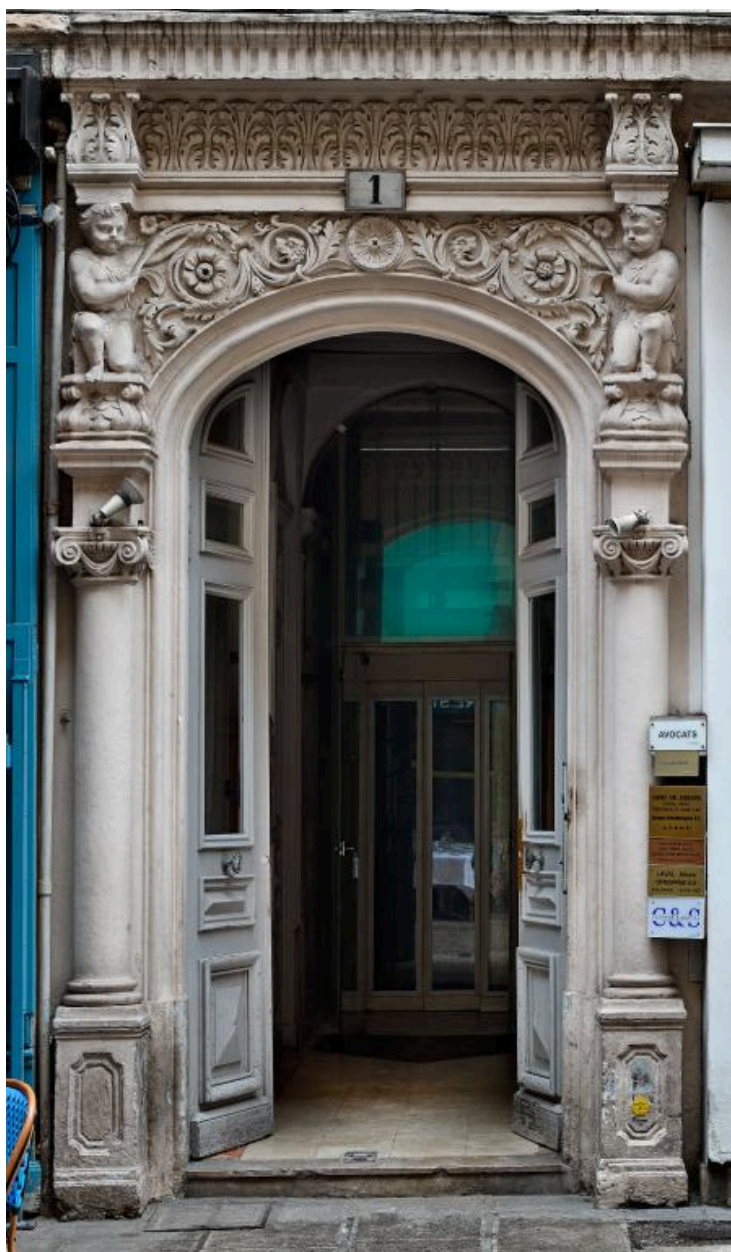
Rue Ferrandière : la porte bâtarde, vue rapprochée
