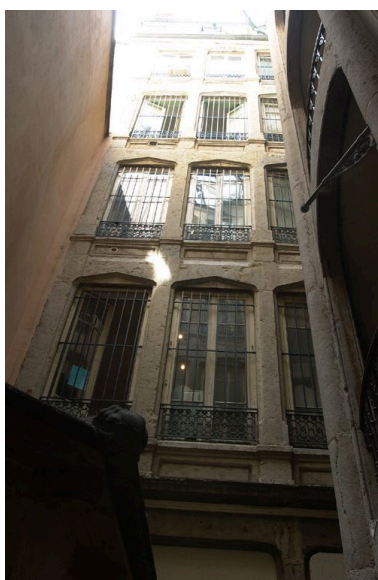
Elévation sur cour du corps de bâtiment est (parcelle AE 135) Phot. Véronique Belle IVR82_20046905273NUCA
