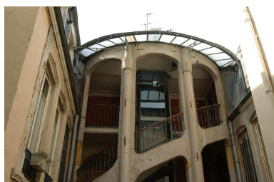
Partie supérieure de la cage d'escalier Phot. David Chevallier IVR82_20046905269NUCA
