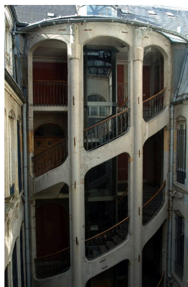
La cage d'escalier depuis celle de l'immeuble sis 42 rue de Brest Phot. David Chevallier IVR82_20046905268NUCA
