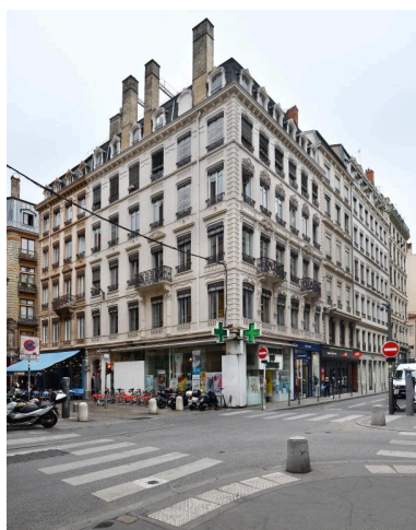
Vue générale sur les rues Ferrandière et de Brest Phot. Thierry Leroy IVR84_20196900537NUCAQ
