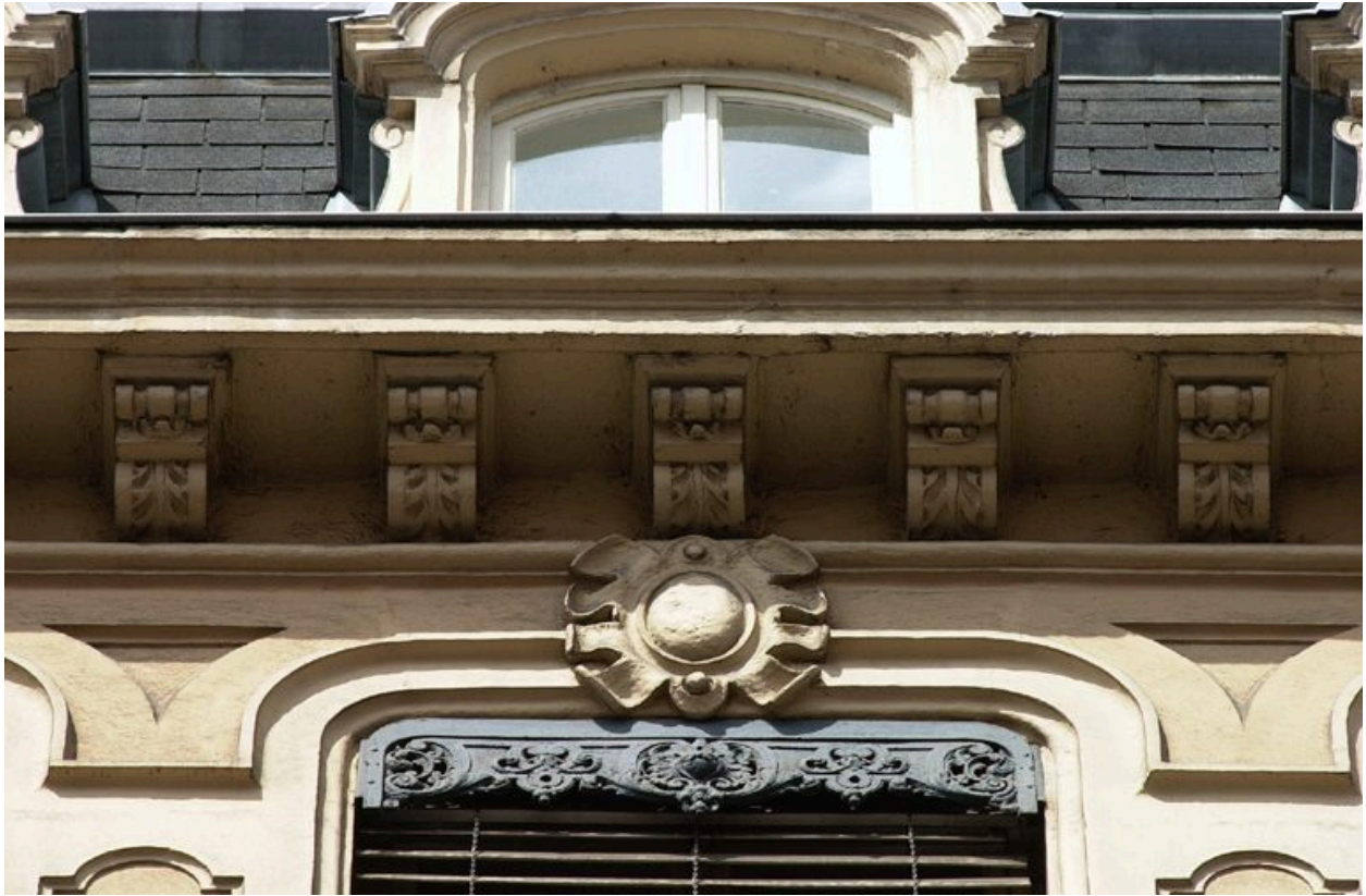
Élévation est, quatrième étage carré : corniche et fenêtre
