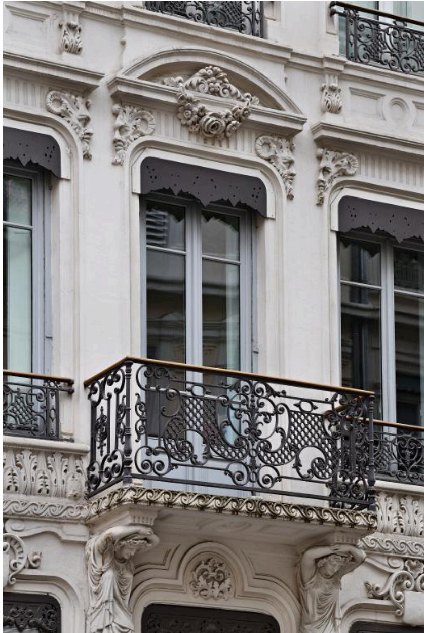
Elévation est, rue de Brest : fenêtre et balcon du deuxième étage carré
