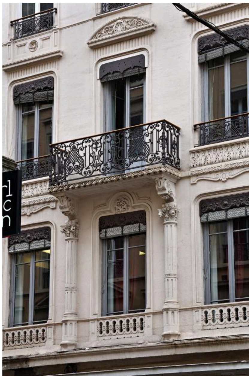
Elévation rue Ferrandière : premier et deuxième étages carrés de la huitième travée
