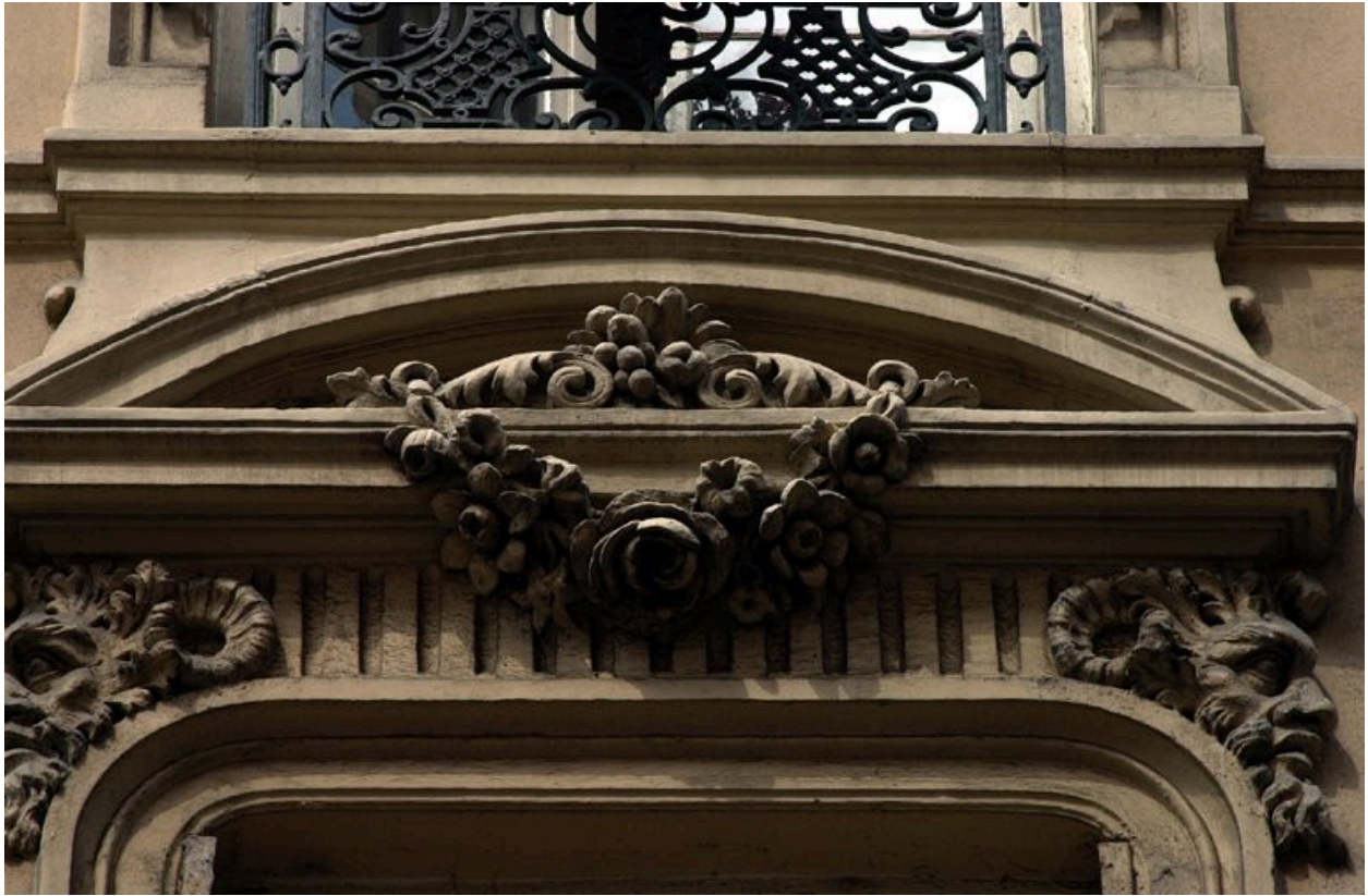
Elévation est, deuxième étage carré : guirlande de fleurs ornant le fronton cintré de l'une des fenêtres
