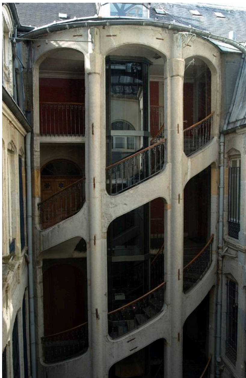
La cage d'escalier depuis celle de l'immeuble sis 42 rue de Brest
