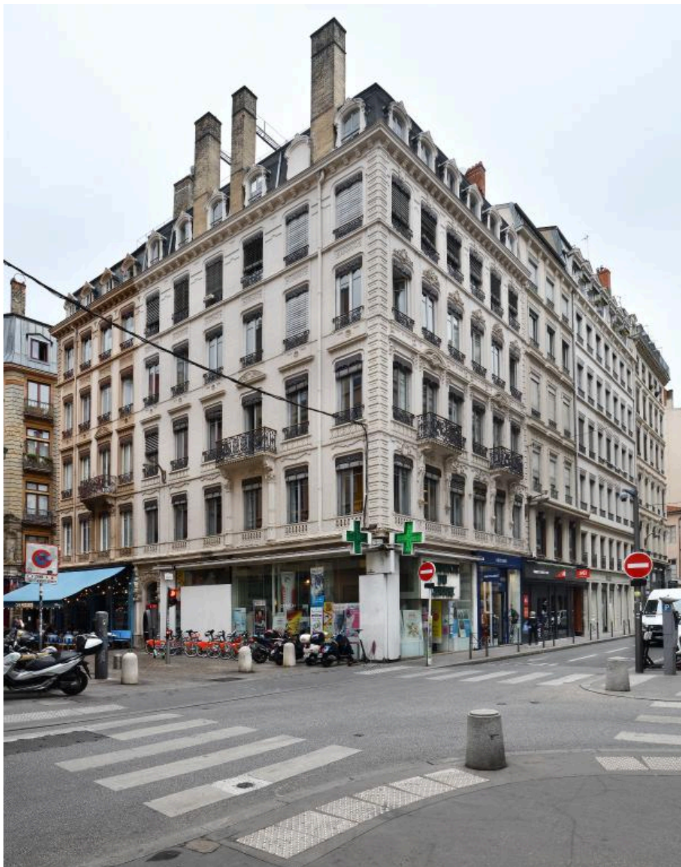
Vue générale sur les rues Ferrandière et de Brest
