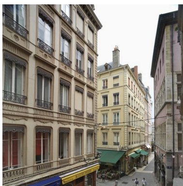
Elévation ouest : les étages carrés au premier plan Phot. Eric Dessert IVR82_20066900535NUCA
