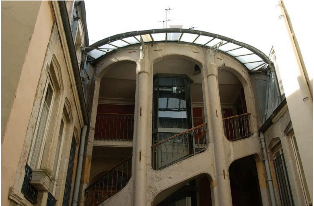
Partie supérieure de la cage d'escalier
