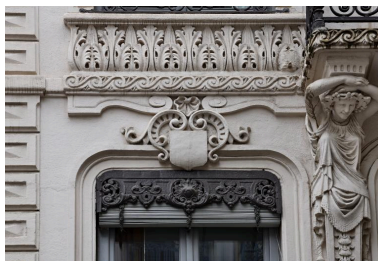
Elévation rue de Brest, premier étage carré : frise d'acanthes, cartouche, écusson muet, lambrequin et terme féminin Phot. Thierry Leroy IVR84_20196900560NUCAQ
