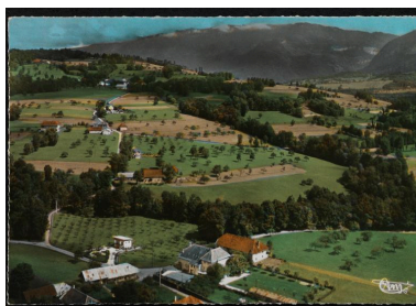
CIM / ST-OURS (Savoie) / 527-84 A – Vue aérienne du Chef-Lieu [Vue de l'écart de la Forêt, depuis le sud-ouest]. Carte postale colorisée, 3e quart 20e siècle (AP Payet-David). Repro. Thierry Leroy, Autr. CIM [Combiér imprimeur à Mâcon] IVR84_20177301857NUCAB
