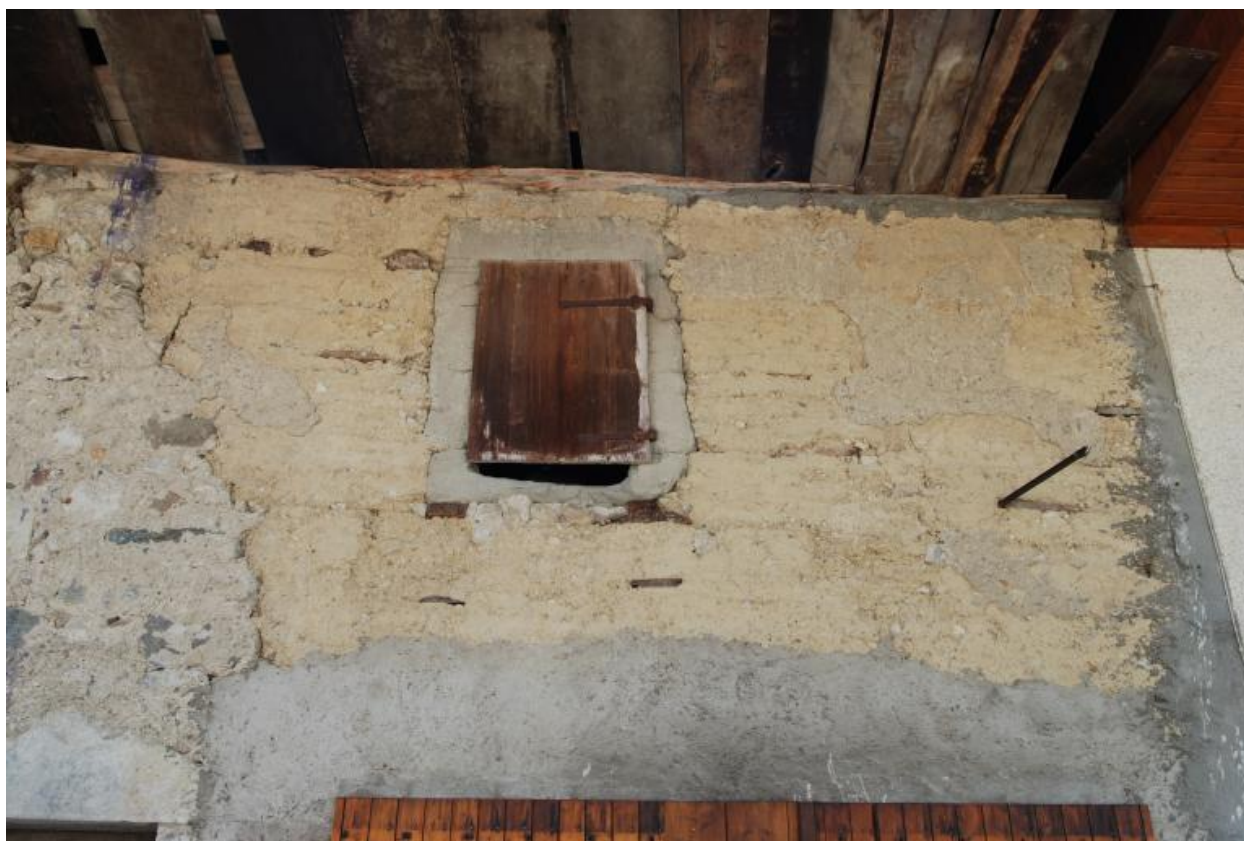
Détail du mur de la grange-étable (pisé).
