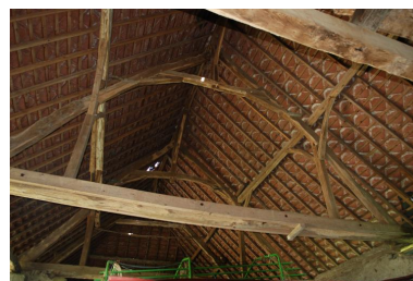
Charpente de la grange-étable. Phot. Thierry Monnet IVR84_20187301344NUCA
