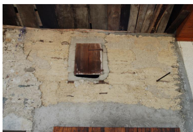
Détail du mur de la grange-étable (pisé). Phot. Thierry Monnet IVR84_20187301345NUCA
