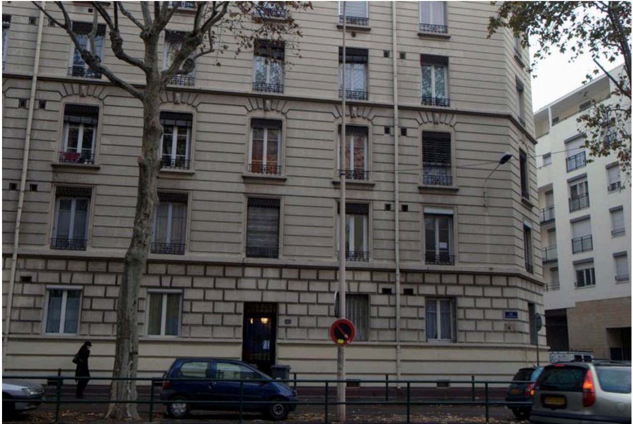
Elévation rue Garibaldi
