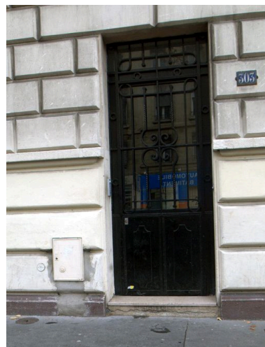
Porte d'entrée Phot. Maryannick Chalabi IVR82_20086900777NUCA
