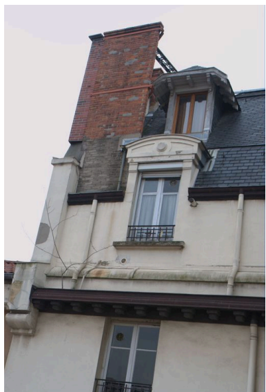
Baies des combles, côté cour Phot. Maryannick Chalabi IVR82_20086900793NUCA
