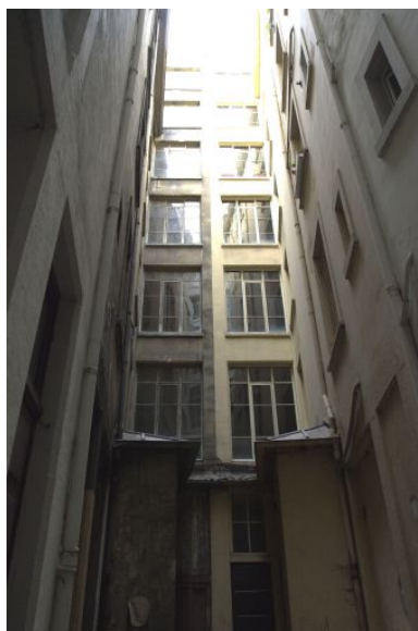
Vue des montées d'escalier parallèles depuis la cour Phot. Maryannick Chalabi IVR82_20016900310NUCA
