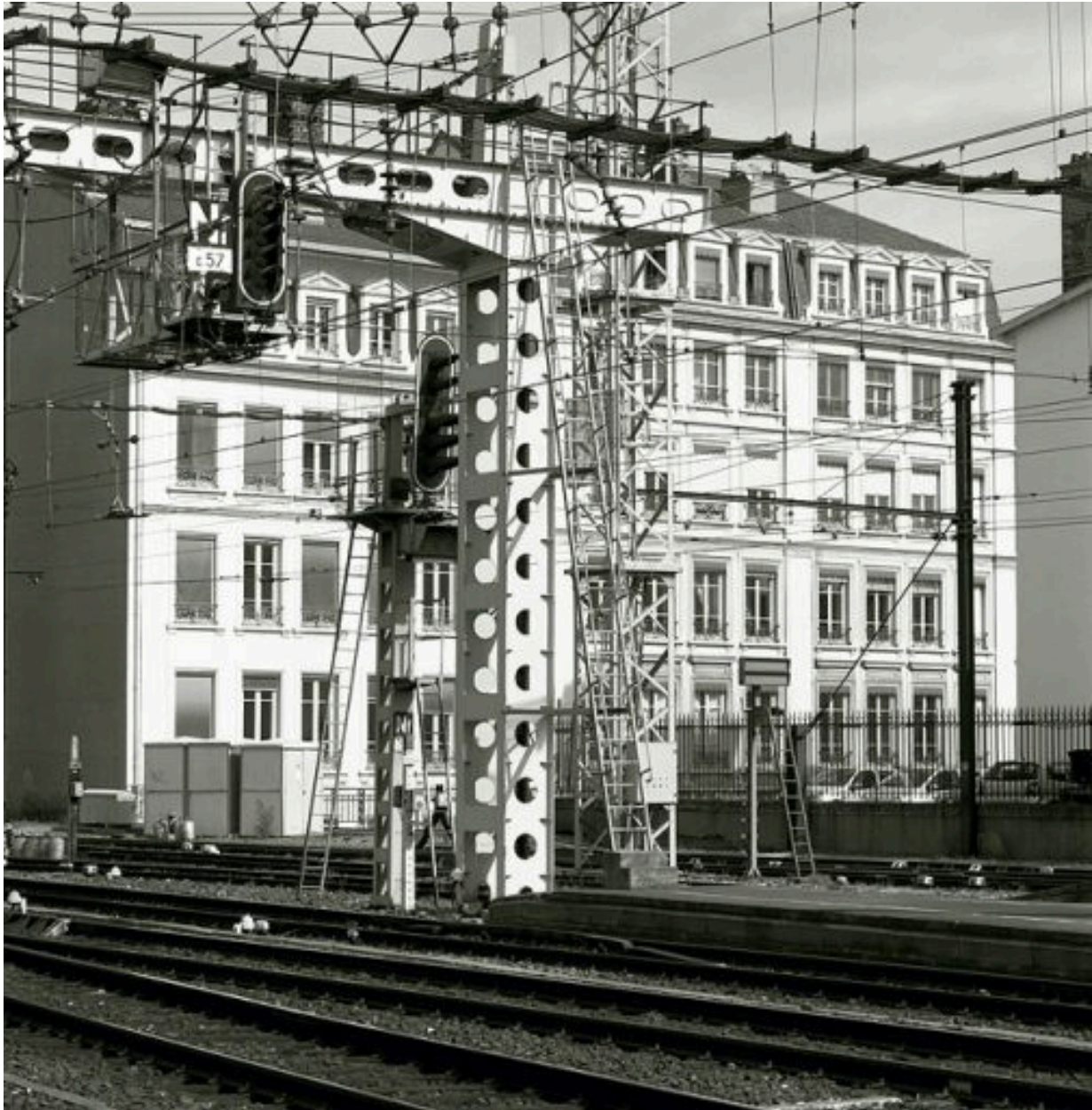
Elévation rue Claudius-Collonge depuis la voie ferrée
