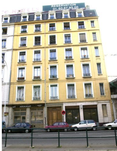
Vue générale, 2 quai Rambaud Phot. Maryannick Chalabi IVR82_20016900327NUCA
