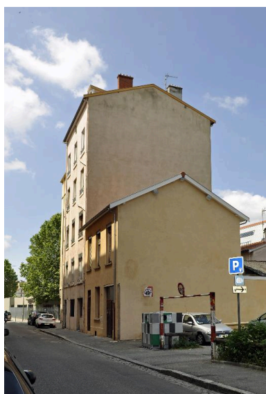
Vue latérale Phot. Catherine Guégan IVR84_20166900727NUCA
