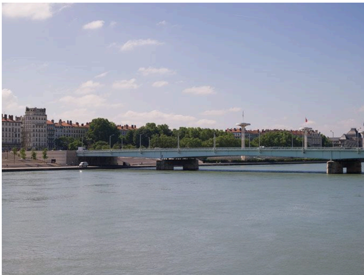
Le pont et son débouché rive gauche depuis le nord-ouest
