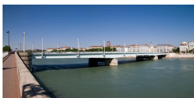
Vue d'ensemble du pont depuis le sud-ouest Phot. Martial Couderette IVR82_20096903601NUCA
