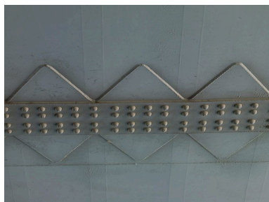
Détail de l'assemblage du tablier du pont Phot. Martial Couderette IVR82_20096903590NUCA
