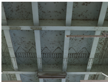
Détail du dessous du tablier du pont depuis le quai bas, rive gauche Phot. Martial Couderette IVR82_20096903585NUCA
