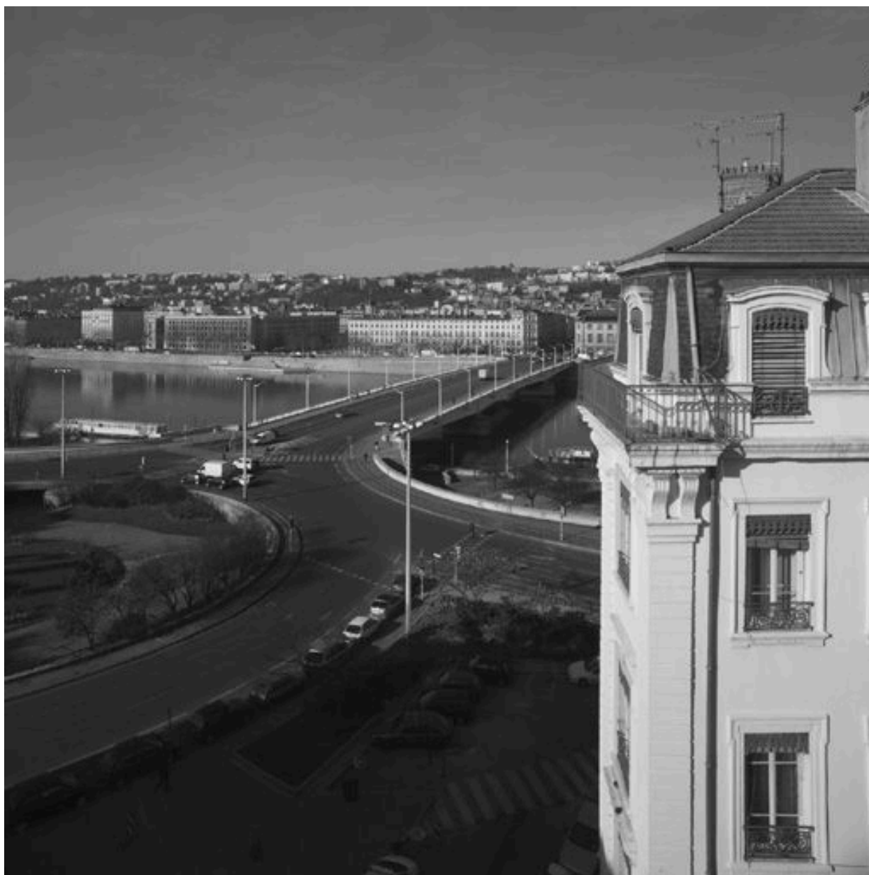
Vue d'ensemble depuis le Palais de la Mutualité au nord-est, photographie prise en 2004
