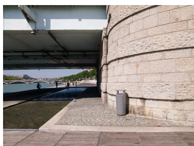
Vue de la culée de la rive gauche depuis le sud Phot. Martial Couderette IVR82_20096903595NUCA
