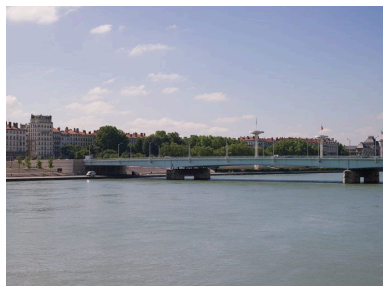
Le pont et son débouché rive gauche depuis le nord-ouest Phot. Martial Couderette IVR82_20096903562NUCA
