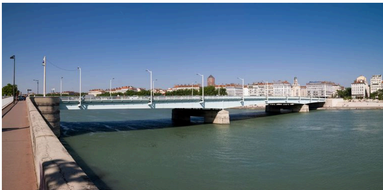
Vue d'ensemble du pont depuis le sud-ouest
