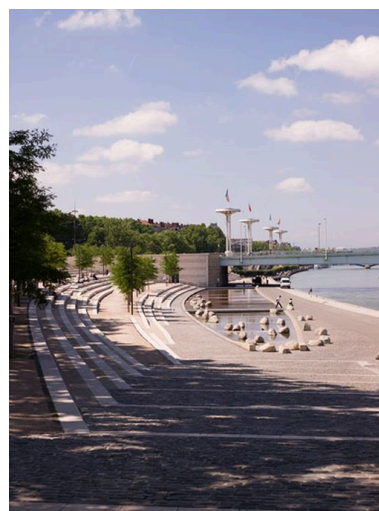
Le débouché du pont rive gauche et les aménagements des berges du Rhône depuis le nord Phot. Martial Couderette IVR82_20096903568NUCA
