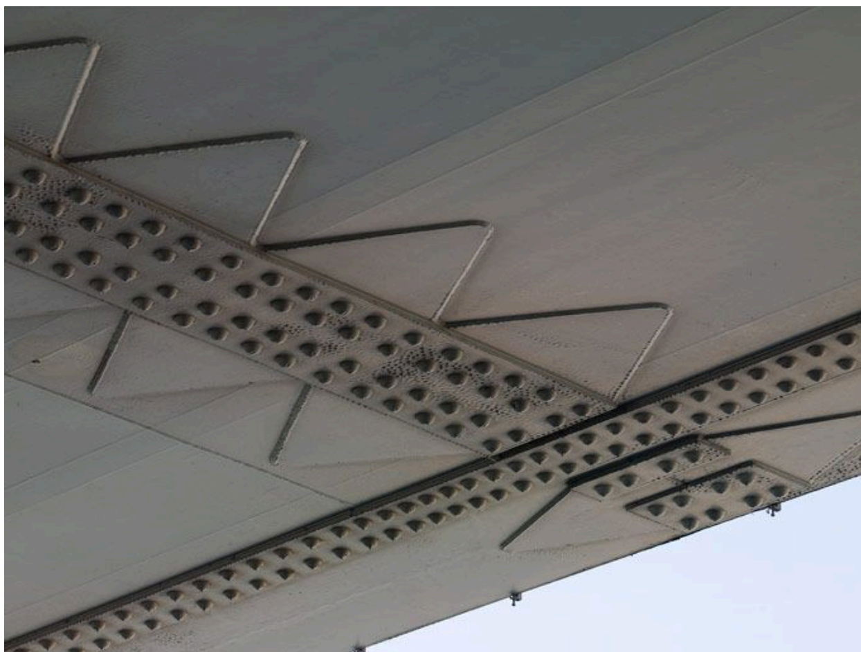
Détail de l'assemblage du tablier du pont
