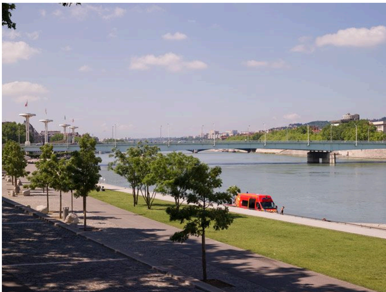
Le pont depuis le nord-est
