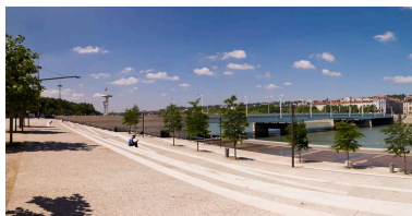
Le pont et les terrasses du Rhône depuis le nord-est Phot. Martial Couderette IVR82_20096903570NUCA
