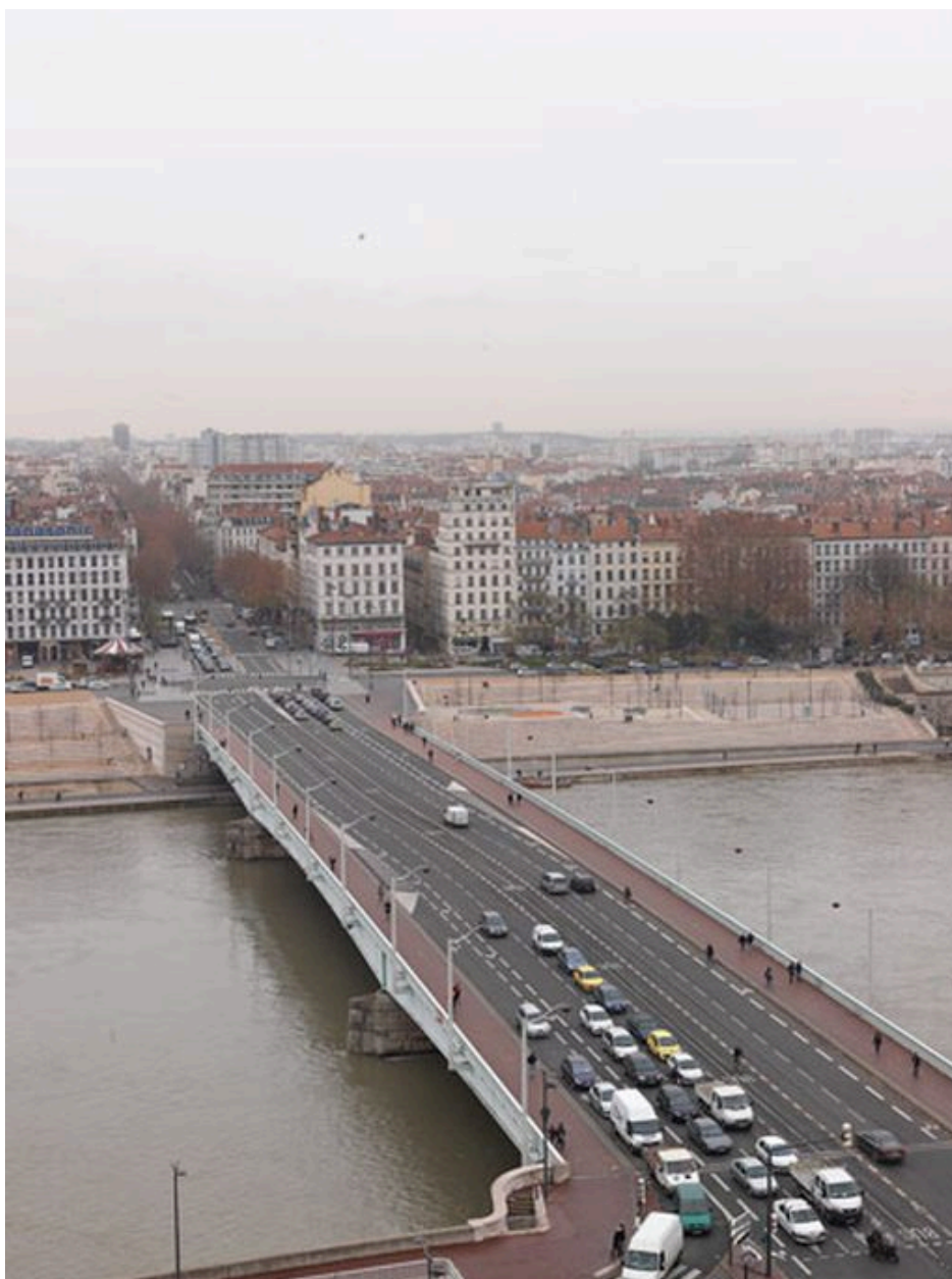
Vue de la chaussée depuis l'hôtel-Dieu au nord-ouest
