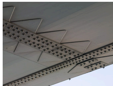
Détail de l'assemblage du tablier du pont Phot. Martial Couderette IVR82_20096903589NUCA
