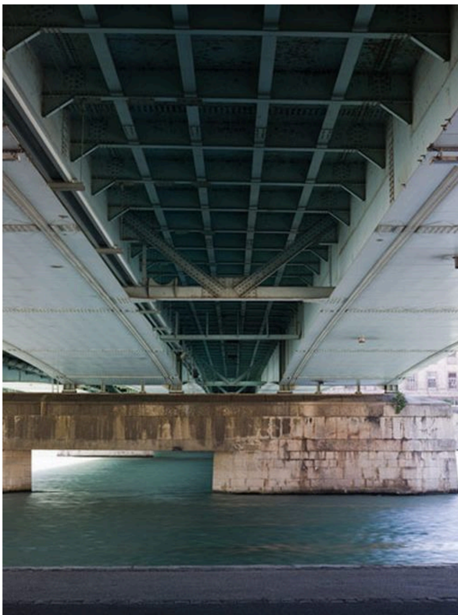
Détail du dessous du tablier du pont depuis le quai bas, rive gauche
