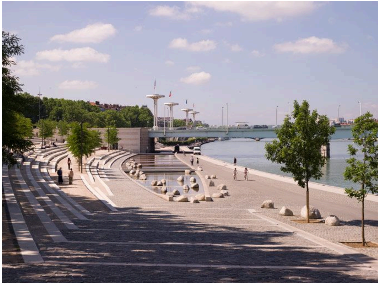
Le débouché du pont rive gauche et les aménagements des berges du Rhône ; à l'arrière les lampadaires de la piscine du Rhône
