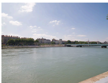
Le pont et la rive gauche vue depuis la rive droite à l'ouest Phot. Martial Couderette IVR82_20096903560NUCA
