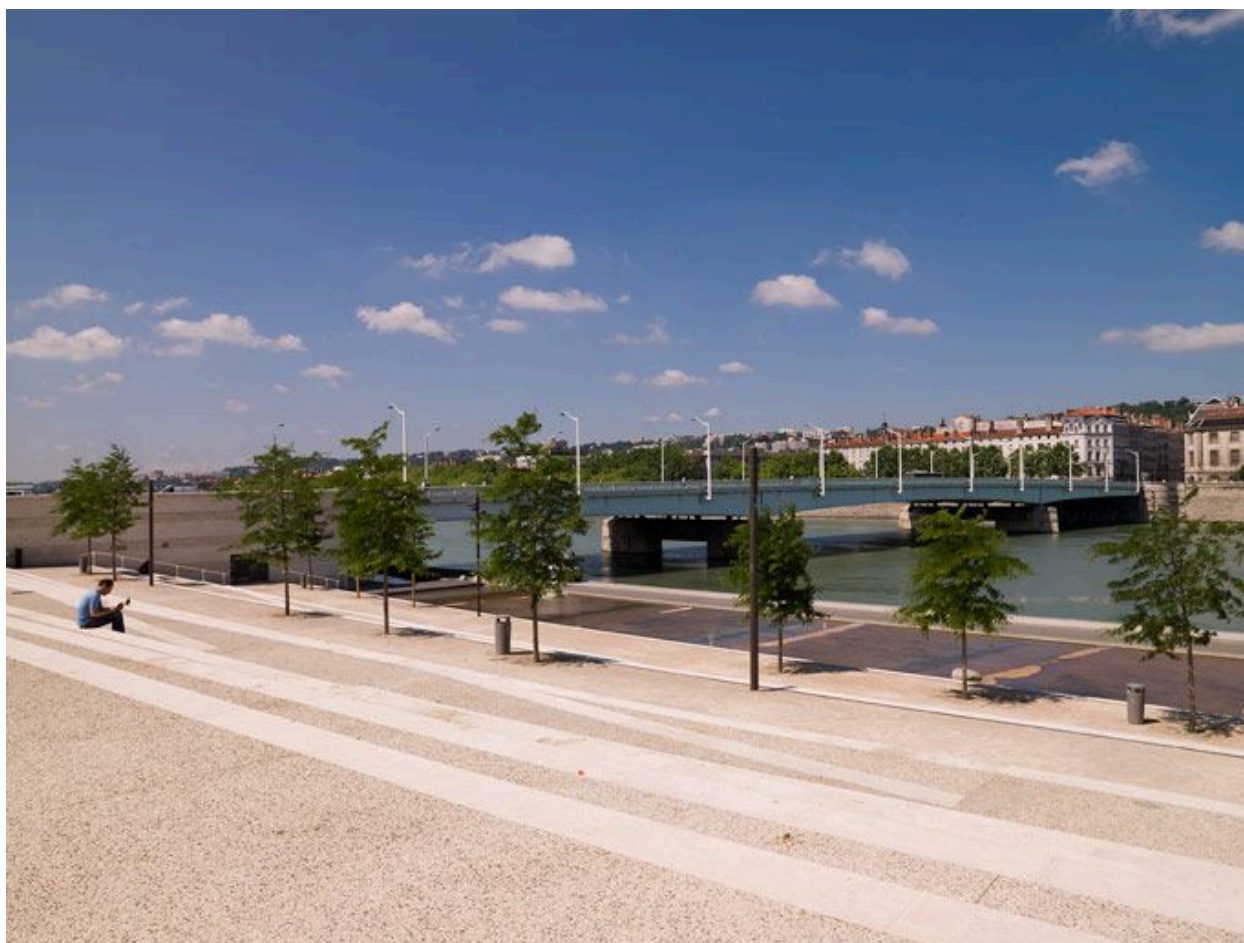
Le pont depuis le nord-est
