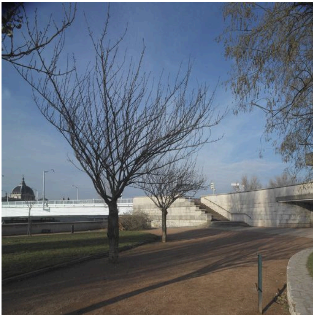
Vue du pont depuis le quai Claude-Bernard au sud, photographie prise en 2004
