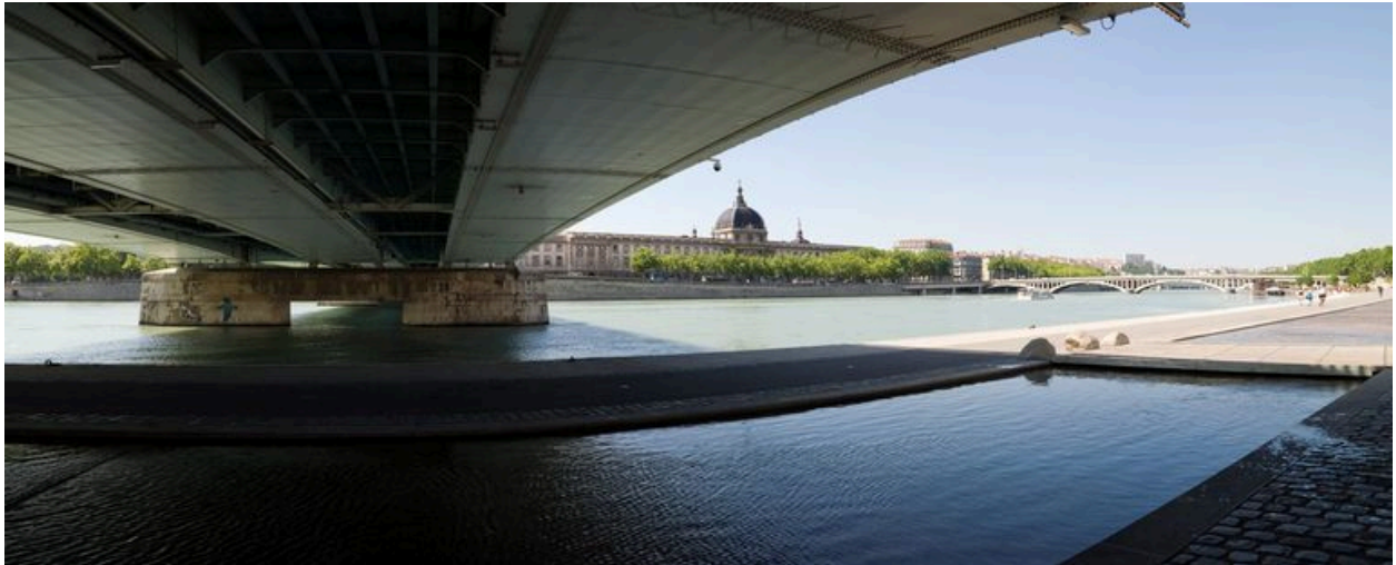
Le tablier du pont depuis le quai bas, côté rive gauche
