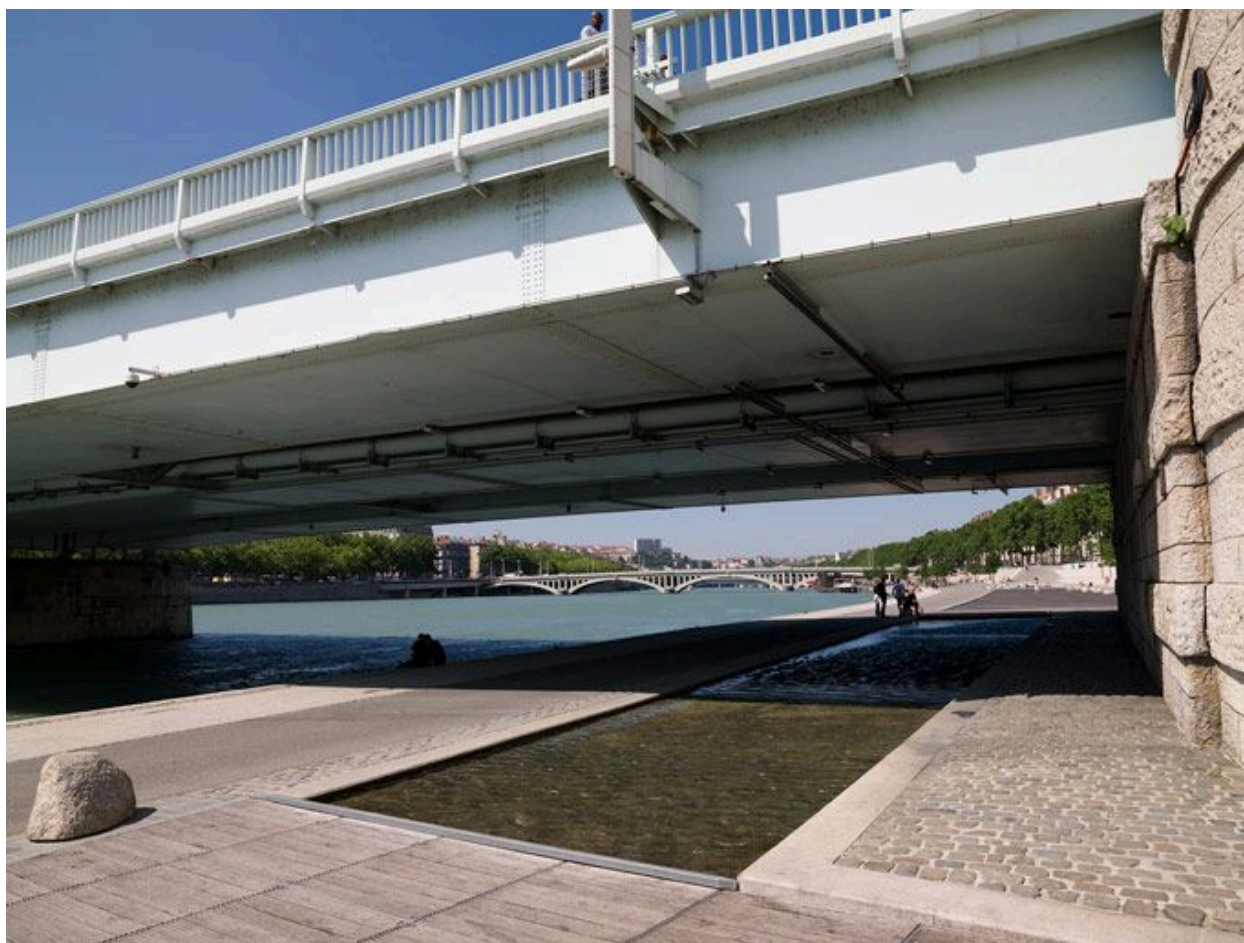
Le tablier depuis le sud
