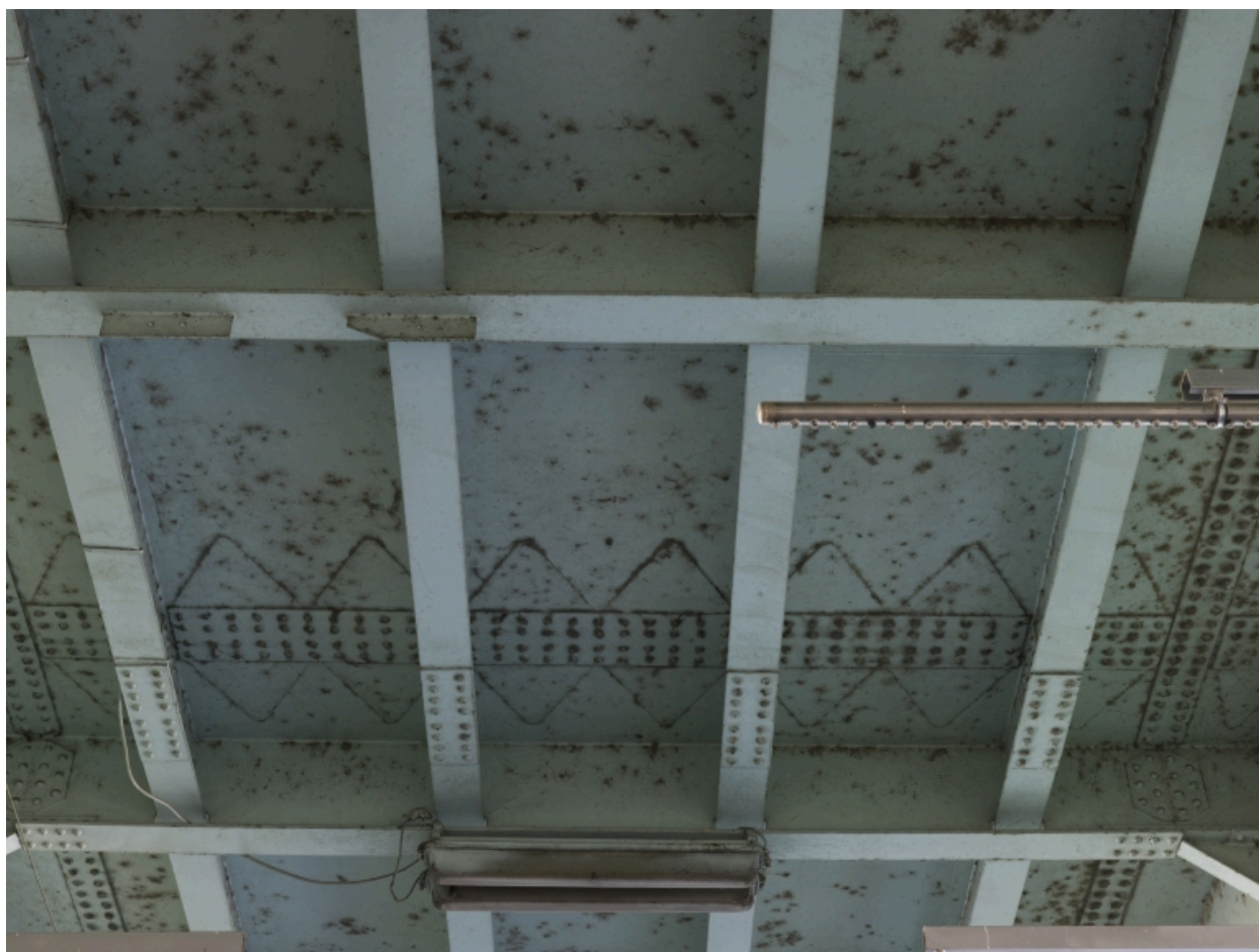
Détail du dessous du tablier du pont depuis le quai bas, rive gauche
