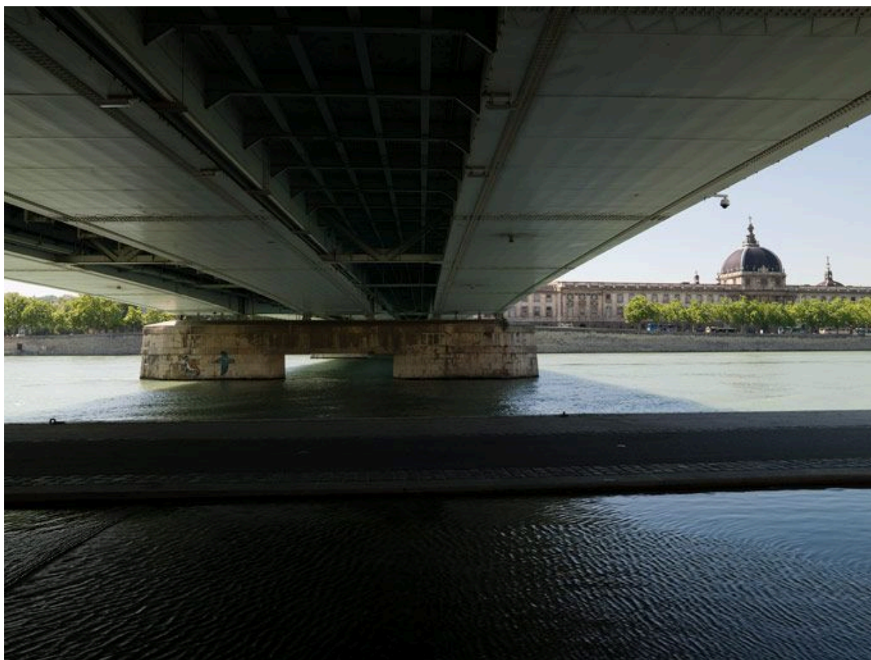
Le tablier et la double pile du pont, côté rive gauche depuis le quai bas
