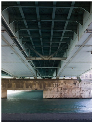
Détail du dessous du tablier du pont depuis le quai bas, rive gauche Phot. Martial Couderette IVR82_20096903588NUCA
