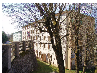
Vue prise du nord-est Phot. François Fouger IVR82_20097300620NUCA
