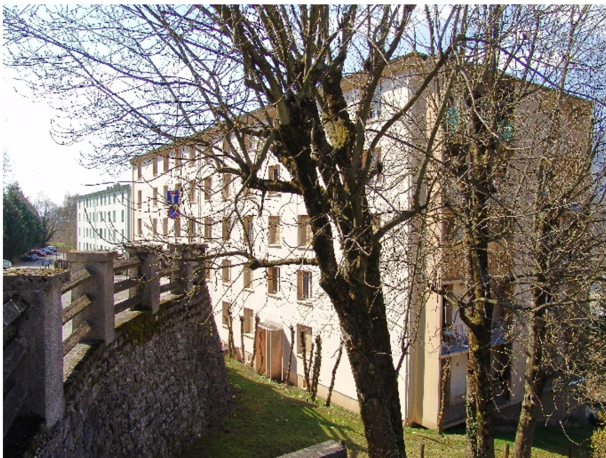
Vue prise du nord-est
