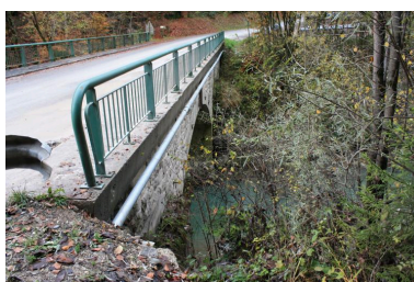
Pont de la Forclaz, détails gardes corps et plinthes Phot. Benoît Huraut IVR84_20207401493NUCA
