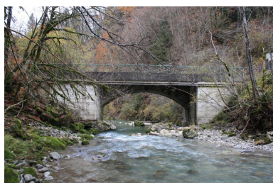
Pont de la Forclaz, face amont Phot. Benoît Huraut IVR84_20207401489NUCA
