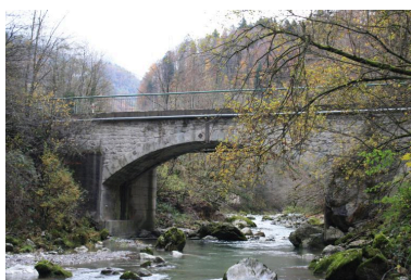
Pont de la Forclaz, face en aval Phot. Benoît Huraut IVR84_20207401490NUCA
