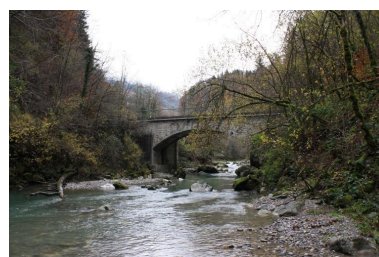
Pont de la Forclaz, Contexte Phot. Benoît Huraut IVR84_20207401488NUCA
