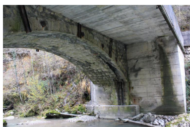
Pont de la Forclaz, détail voûte et culée Phot. Benoît Huraut IVR84_20207401492NUCA
