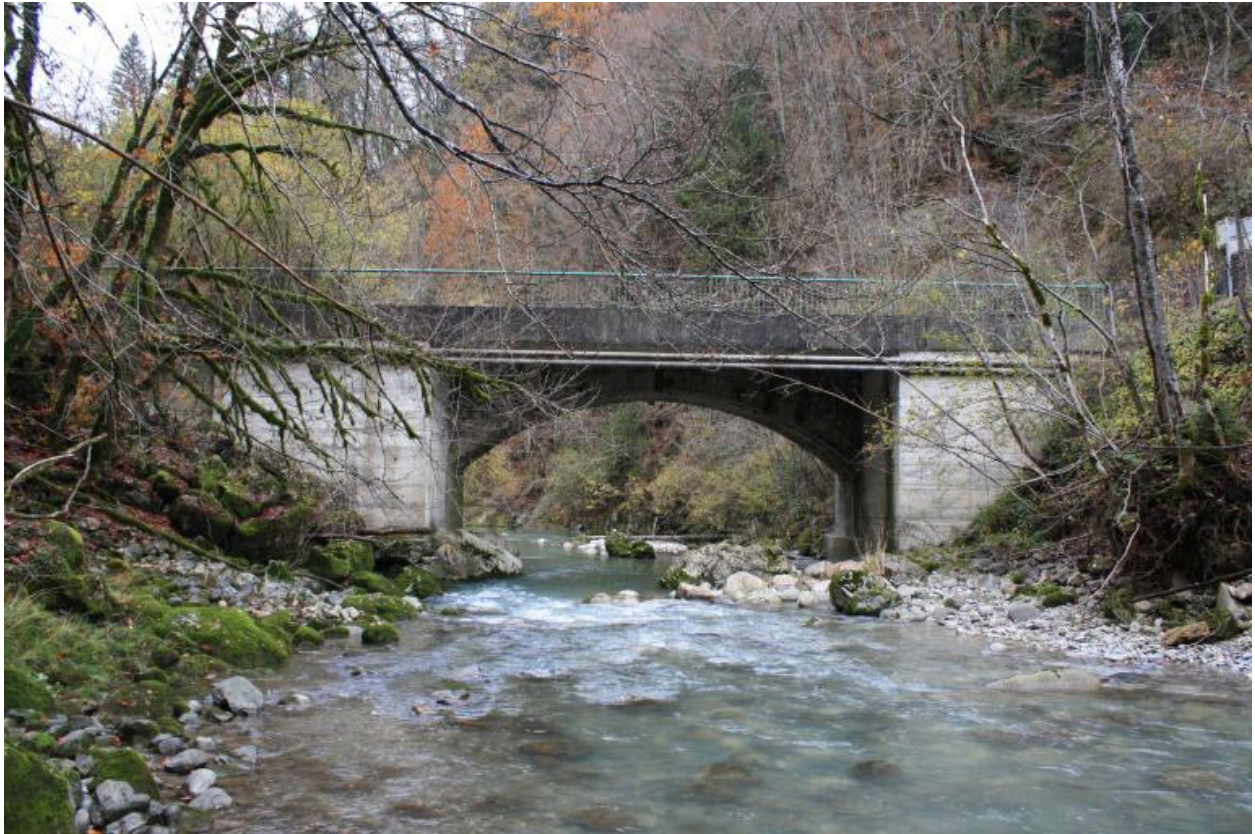
Pont de la Forclaz, face amont
