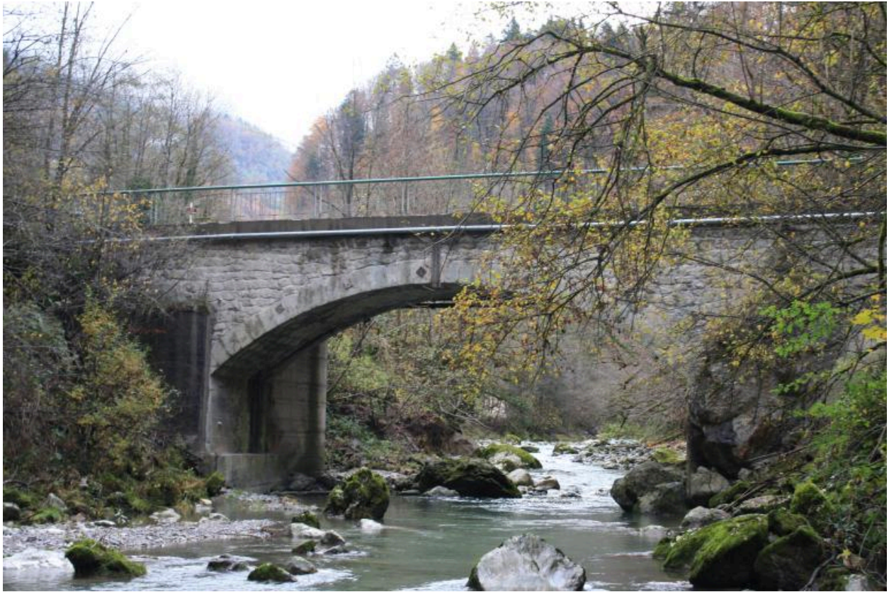
Pont de la Forclaz, face en aval
