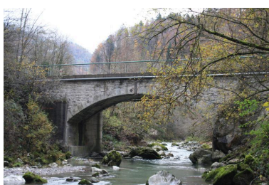
Pont de la Forclaz, face en aval Phot. Benoît Huraut IVR84_20207401490NUCA
