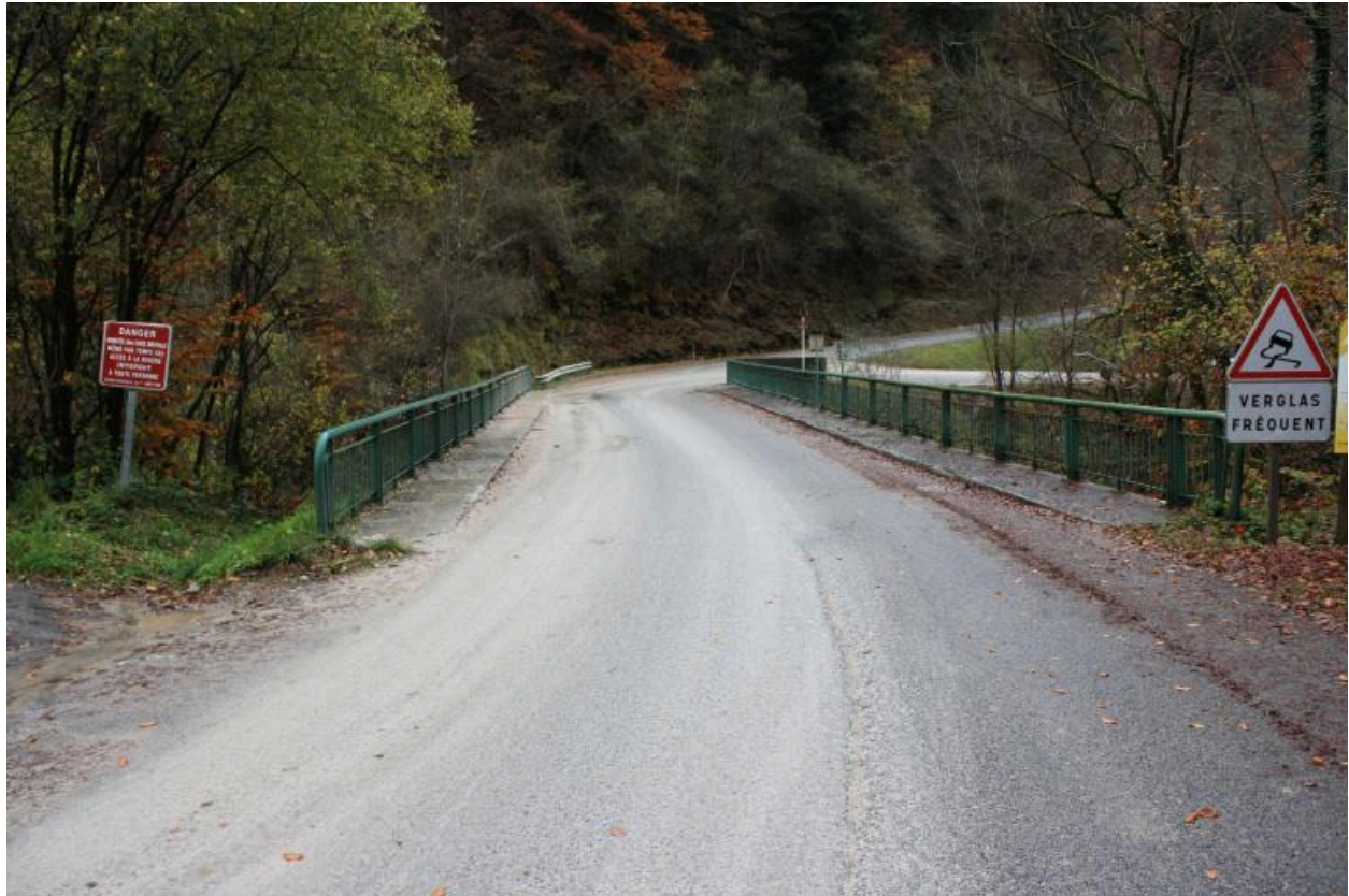
Pont de la Forclaz, chaussée et gardes corps
