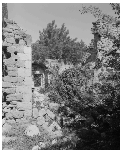
Vestiges de l'église. Phot. Alain Franchella IVR82_19972600220X
