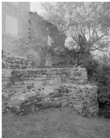
Vestiges de l'église. Phot. Alain Franchella IVR82_19972600228X
