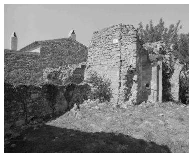
Vestiges de l'église. Phot. Alain Franchella IVR82_19972600222X
