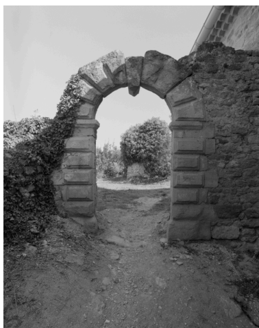
Vestiges de l'église. Phot. Alain Franchella IVR82_19972600221X
