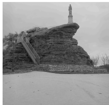
Vue d'ensemble. Phot. Alain Franchella IVR82_19992600608X
