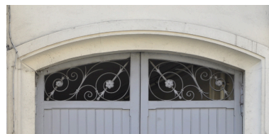
Elévation antérieure, détail de l'imposte de la porte cochère Phot. Catherine Guégan IVR82_20126902418NUCA
