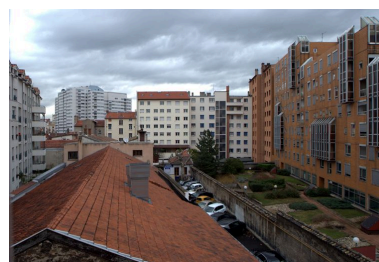
Elévation postérieure depuis le sud Phot. Maryannick Chalabi IVR82_20096901247NUCA
