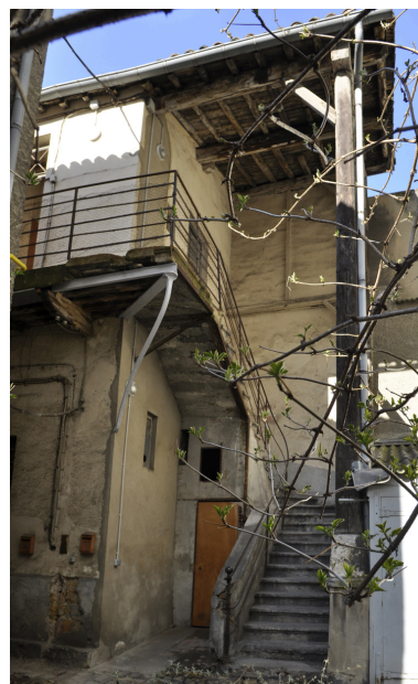
Vue de l'escalier extérieur du bâtiment de la cour Phot. Catherine Guégan IVR82_20126902420NUCA
