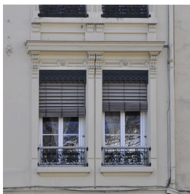
Elevation antérieure, détail des fenêtres du 1er étage Phot. Catherine Guégan IVR82_20126902414NUCA
