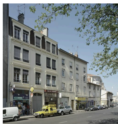
Vue d'ensemble depuis le nord-est Phot. Eric Dessert IVR82_20076902417NUCA
