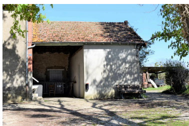
Vue du préau. Phot. Cécile Breton IVR84_20240300033NUC4A
