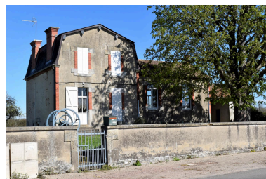
Vue générale Phot. Cécile Breton IVR84_20240300030NUC4A
