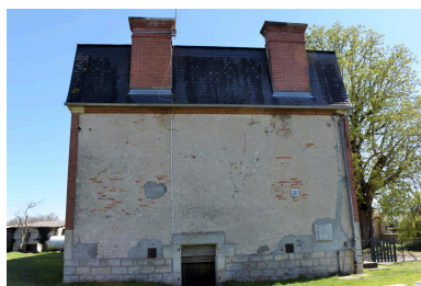
Vue de la façade nord Phot. Cécile Breton IVR84_20240300032NUC4A
