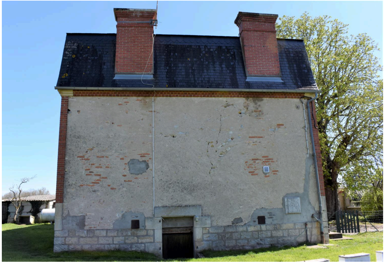
Vue de la façade nord
