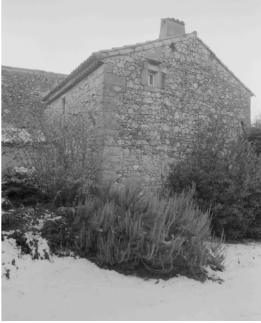
Vue de trois quarts de l'ancienne magnanerie. Phot. Alain Franchella IVR82_19982600077X
