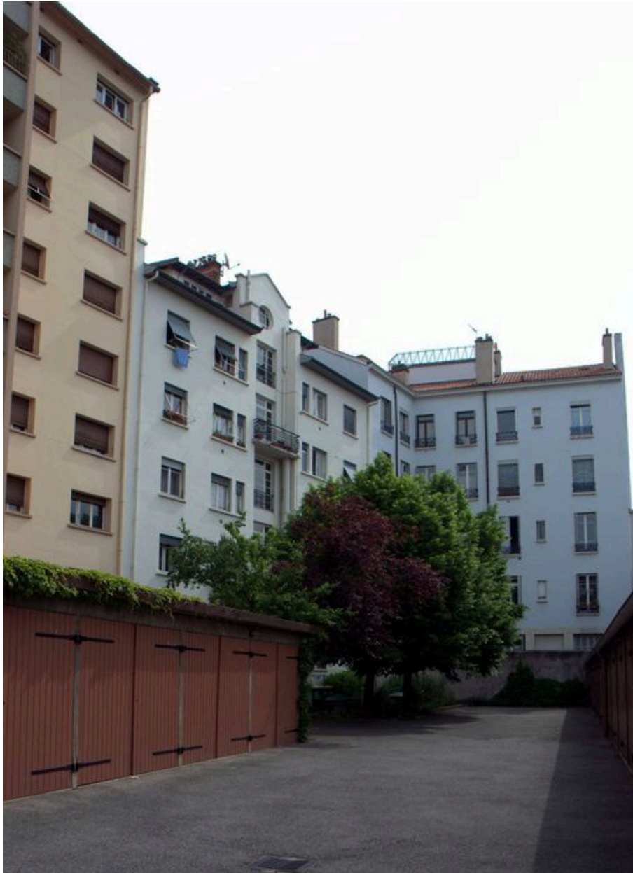
Vue de la cour et des garages depuis l'ouest
