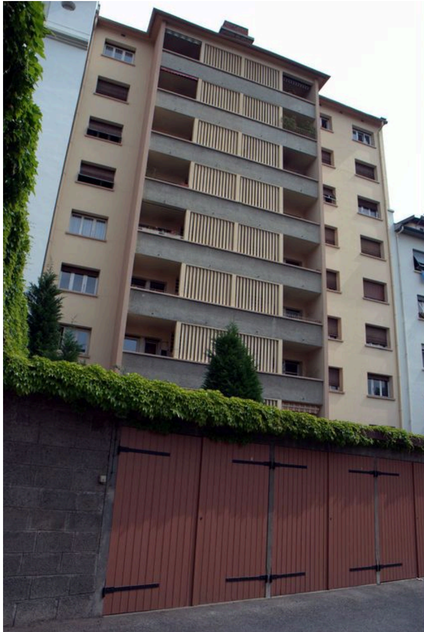
Elévation postérieure, garages au 1er plan
