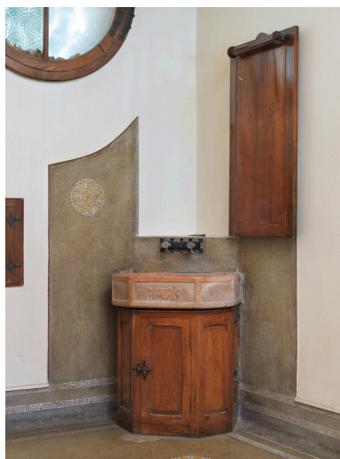
Vestibule : lave-mains maçonné et miroir pivotant porte-essuie-mains (ouvert) Phot. Thierry Leroy IVR84_20216900837NUCAQ
