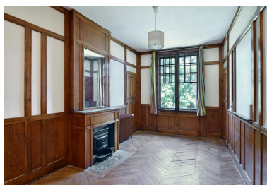
Premier étage, deuxième chambre centrale : vue prise de l'ouest Phot. Thierry Leroy IVR84_20216900907NUCAQ
