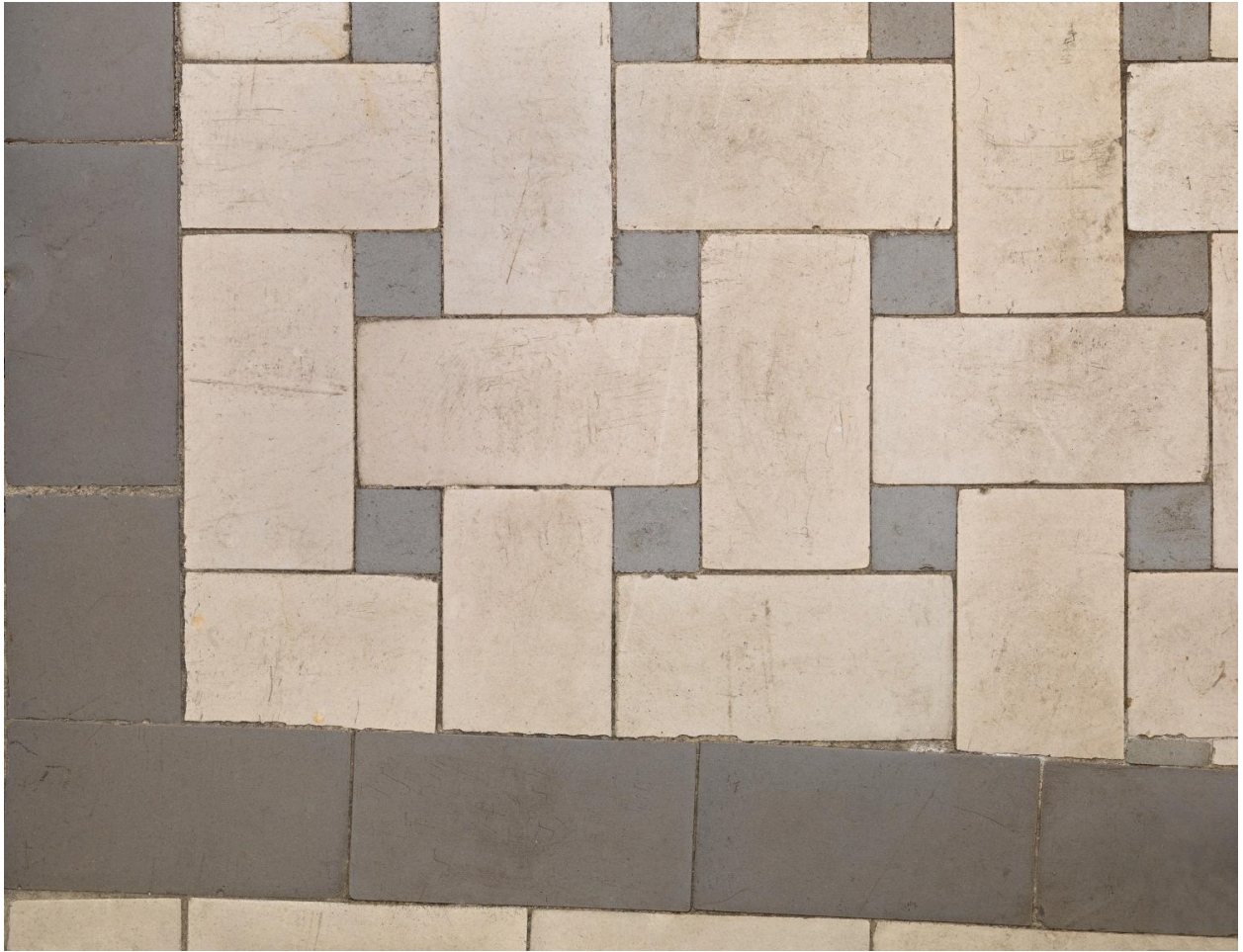
Premier étage, première chambre au sud : pavement de l'alcôve, carreaux d'origine
