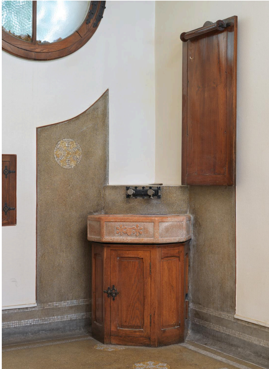
Vestibule : lave-mains maçonné et miroir pivotant porte-essuie-mains (ouvert)
