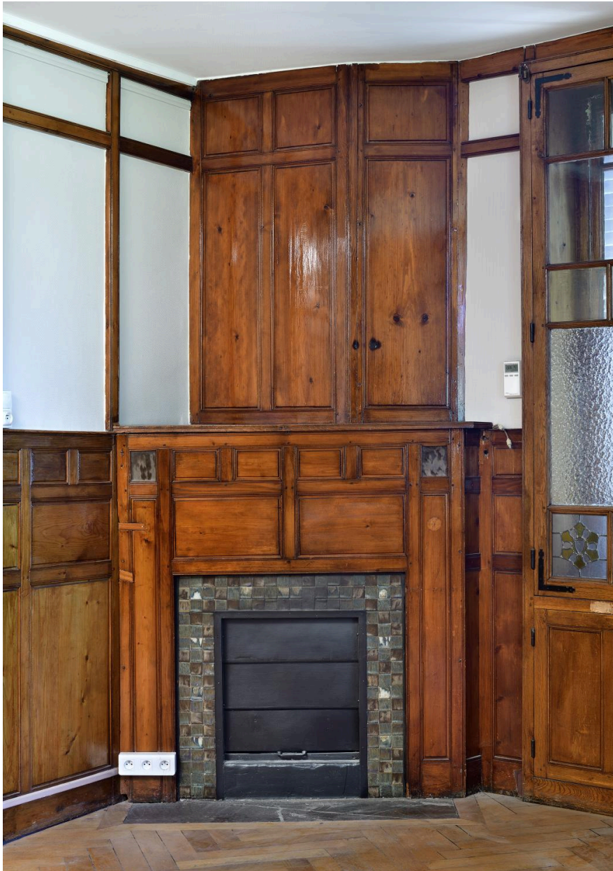
Bibliothèque, vue des lambris et de la cheminée à incrustations de grès flammé
