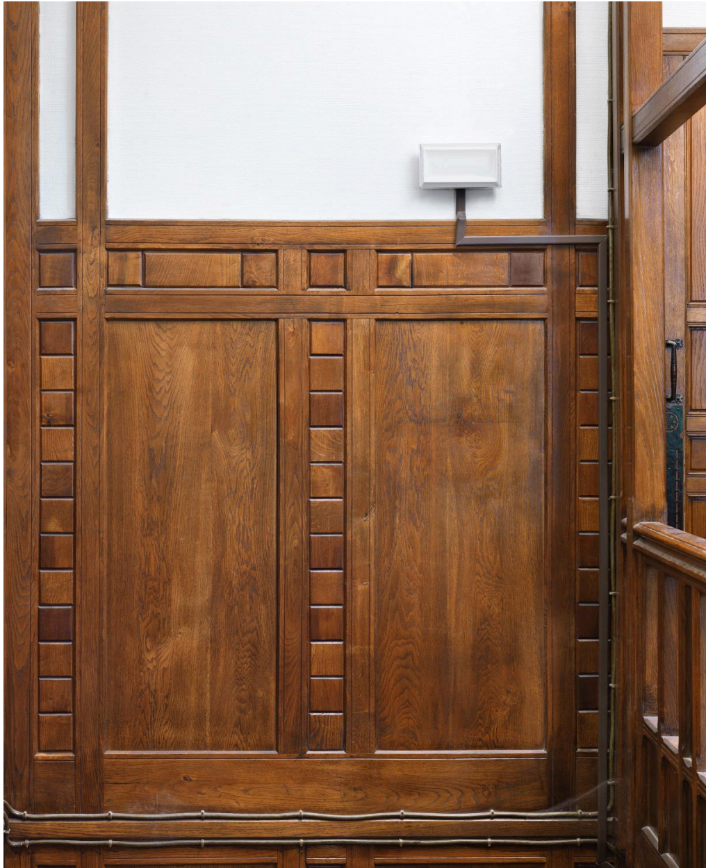
Palier du premier étage, détail du lambris à motifs de damiers
