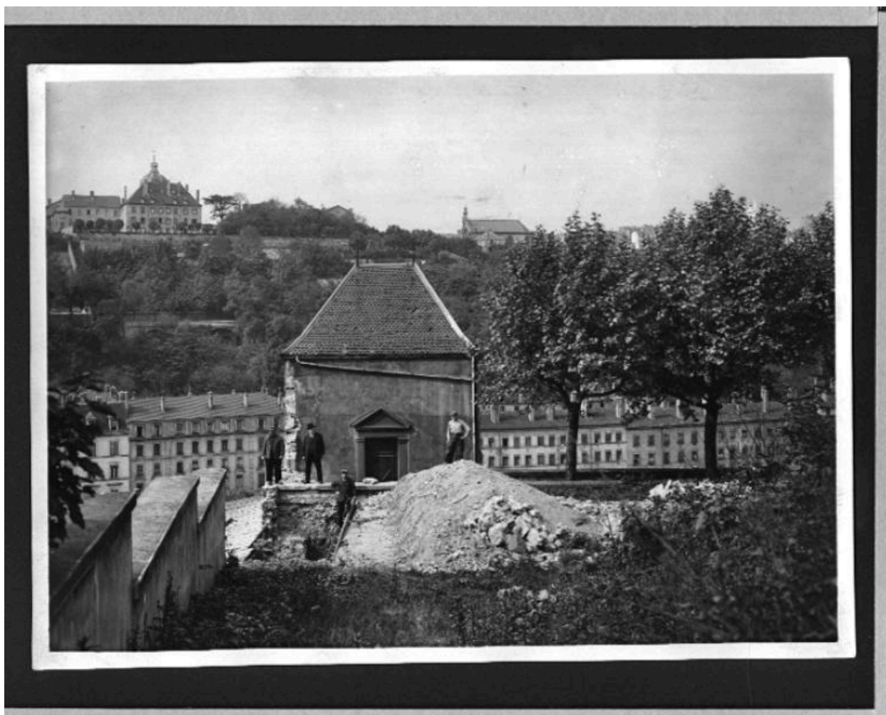
Travaux de consolidation du rocher des Carmes : vue de la façade sud du pavillon / A. Croizat [1925-1928] (AC Lyon, 1 PH 1052/2)
