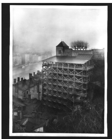
Travaux de consolidation du rocher des Carmes : vue du pavillon et de l'échafaudage / A. Croizat [1925-1928]. (AC Lyon, 1 PH 1052/4). Autr. A. Croizat IVR82_20146902857NUCB
